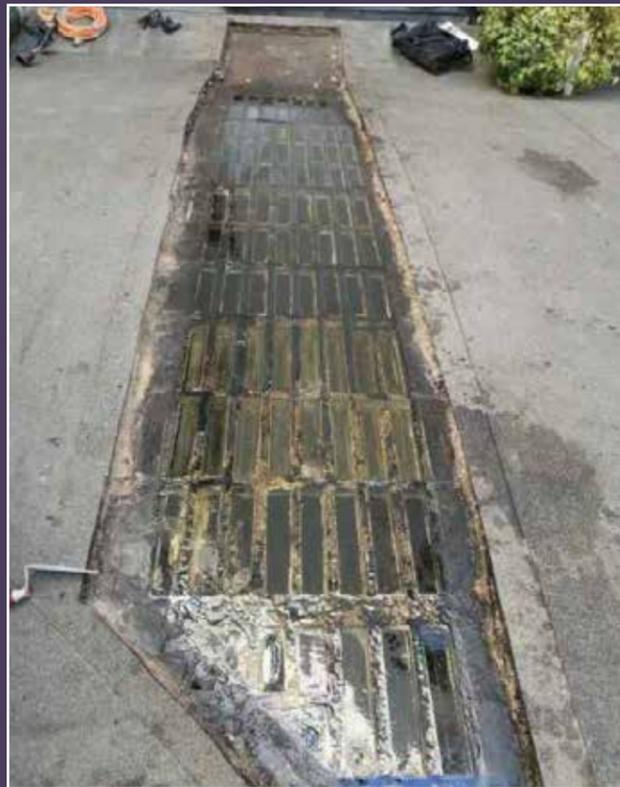
Sondage dans l'étanchéité de la coupole de verre, 2022 (© Archibuilt).
