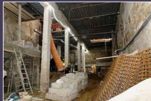
Vue actuelle du sous-sol suite à la démolition des caves, le creusement et la réalisation de la structure en béton armé en infrastructure.
