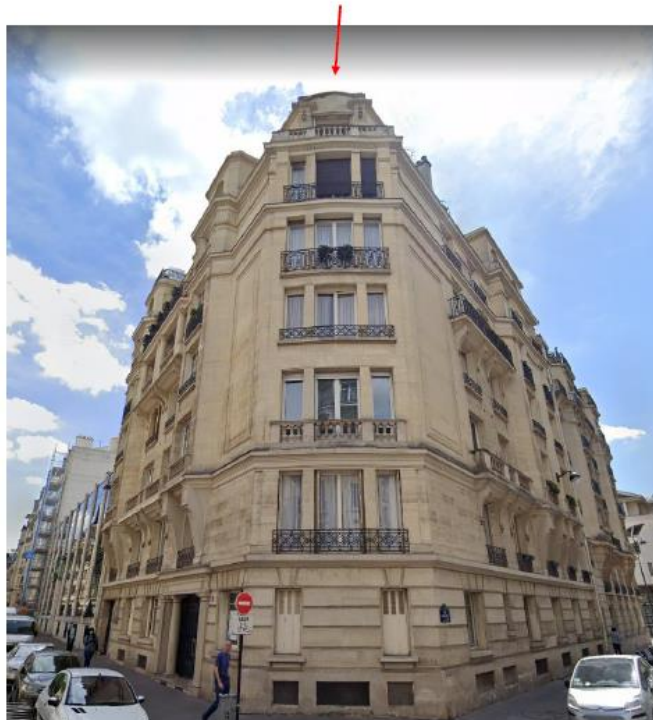
Les antennes non visibles depuis la rue
