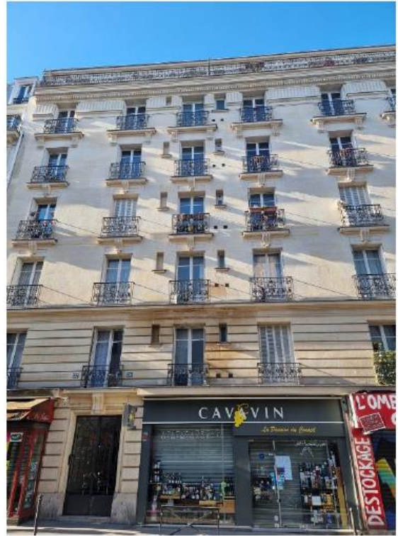
Les antennes non visibles depuis la rue
