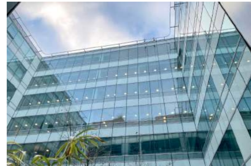
3 Façades sur cour
