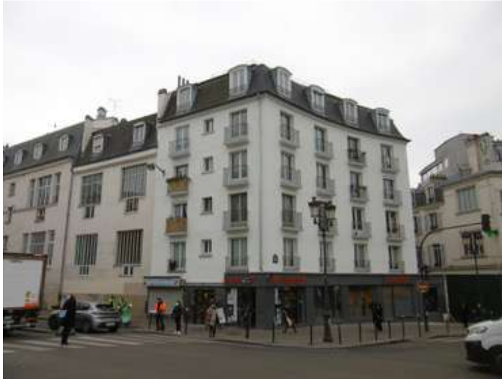
Façades sur boulevard isolée à l'enduit isolant Fixit (demande ABF)
