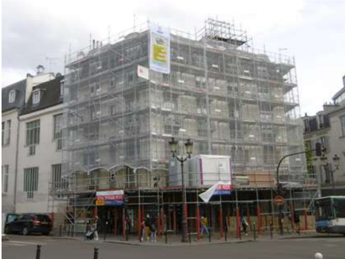
Échafaudage façades rue
