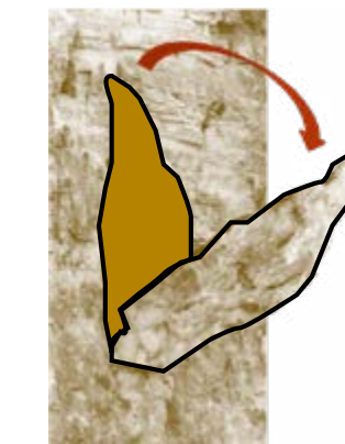
La partie fragilisée se détache...
