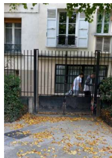
Entrée condamnée passage Dumas
