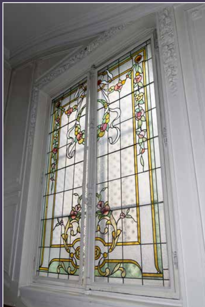
Vue des vitraux de la cage d'escalier.
