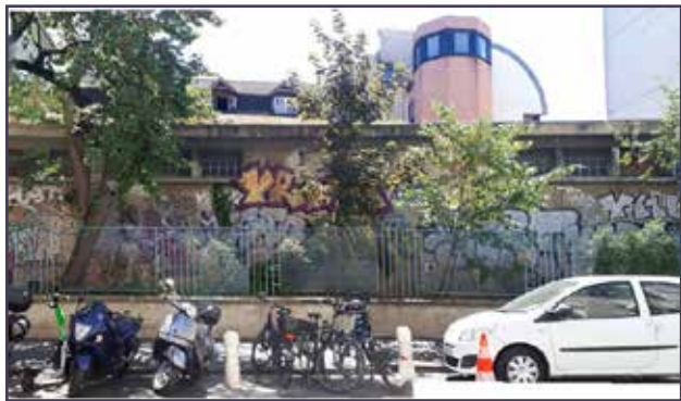
Vue actuelle l'ancienne chaufferie de l'hôpital, depuis la rue (© Wilmotte & Associés).
