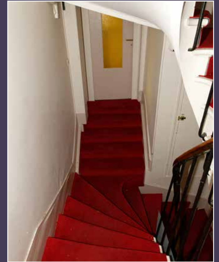
Vue de l'escalier principal et d'un emmarchement de jonction entre les deux corps de bâtiments réunis.
