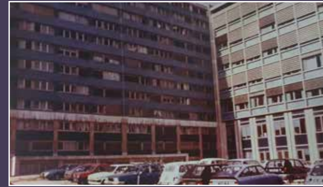
Vue de fin de chantier. À gauche, l'hospice. À droite, la clinique, s.d. (Archives des Quinze-Vingts).
