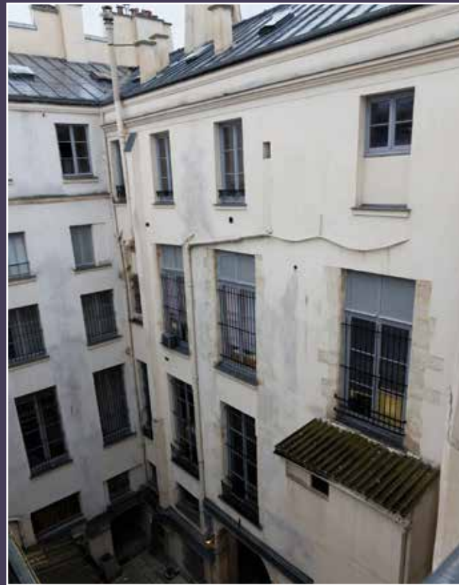
Vue actuelle de la façade sur cour du corps de logis principal.
