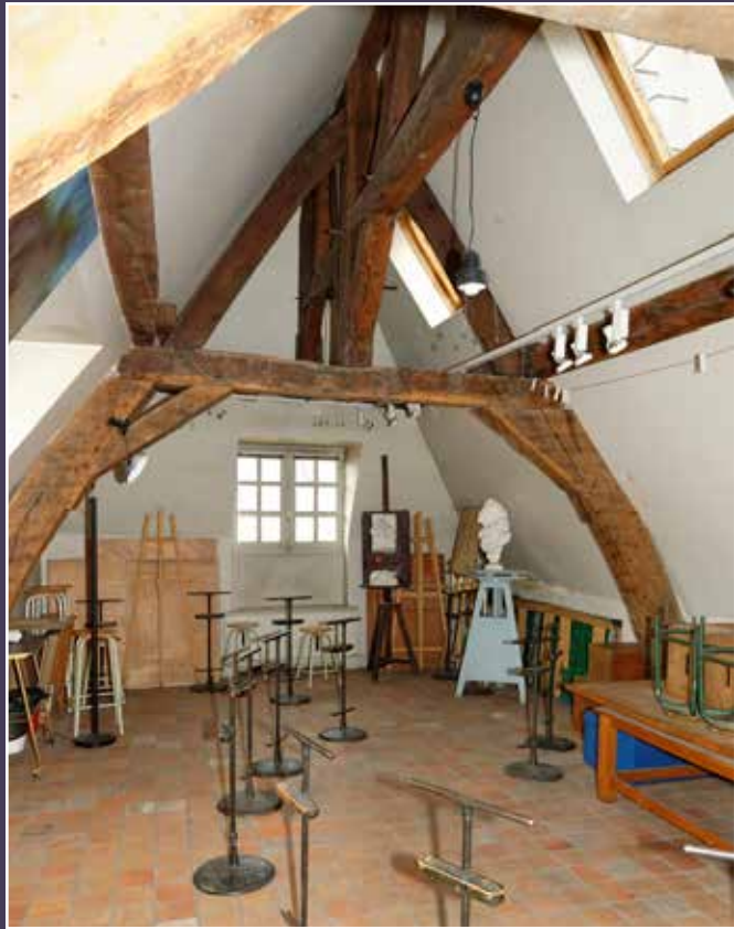
Vue de la volumétrie sous combles.
