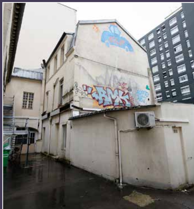
Vue depuis la cour du corps de logis sur rue et aile en retour d'origine.
