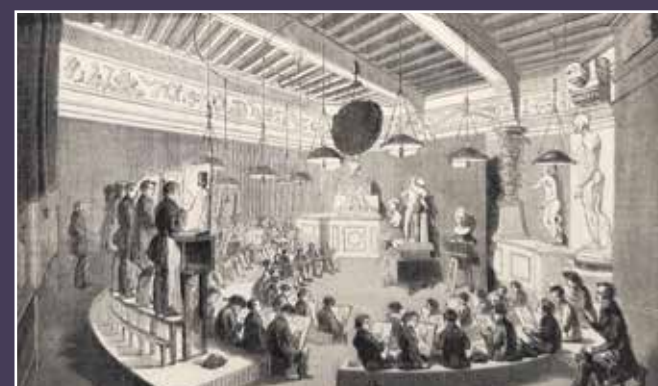
Salle de cours (bâtiment intermédiaire ?), av. 1877.
