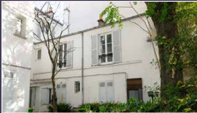
Vue de l'aile élevée sur cour.
