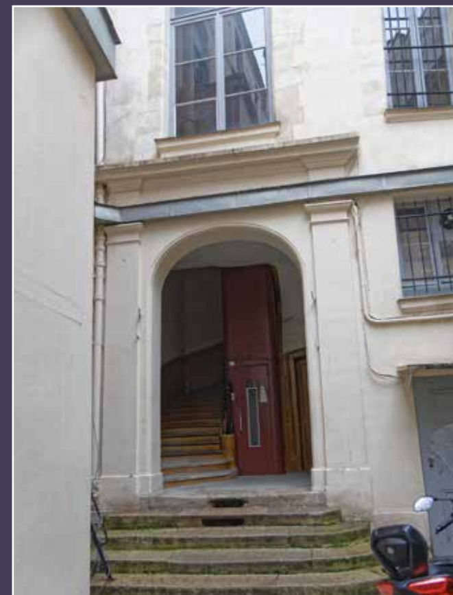
Vue actuelle du perron qui donne accès à l'escalier principal.
