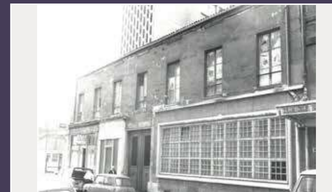
Vue de l'immeuble démolì au 19 rue Moreau, août 1974 (Casier archéologique).
