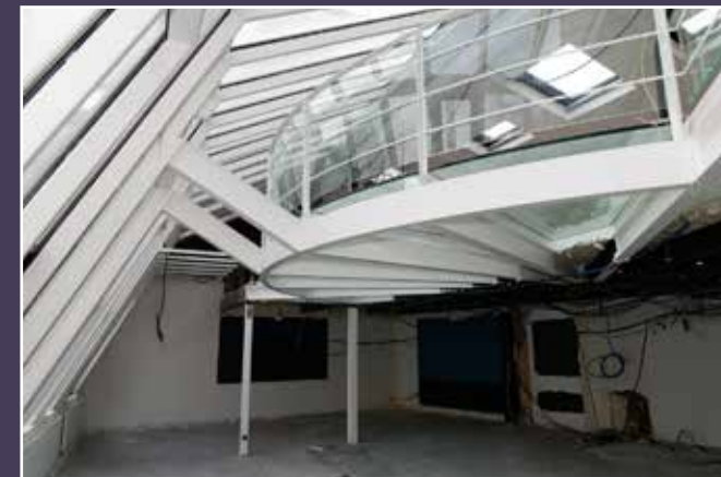
Vue actuelle de la structure métallique de la mezzanine sous les combles du bâtiment en fond de parcelle.
