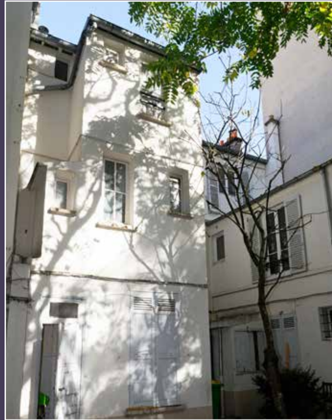
Vue sur cour de l'avant-corps adossé à la façade arrière du bâtiment sur rue.
