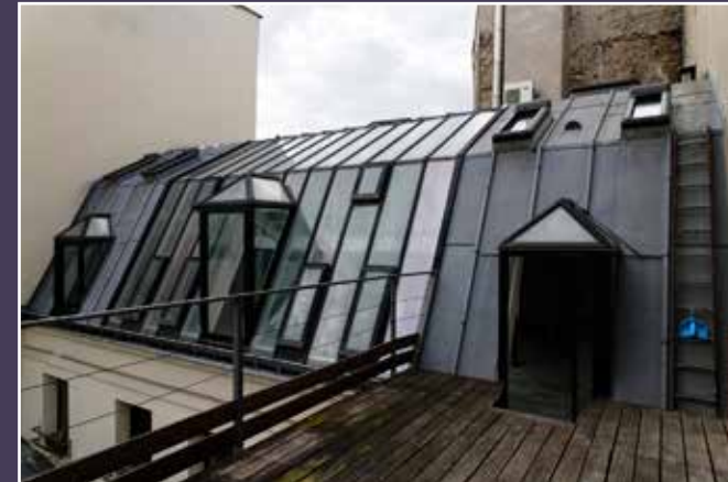
Vue actuelle de la toiture du bâtiment en fond de parcelle depuis la terrasse accessible de l'aile droite.
