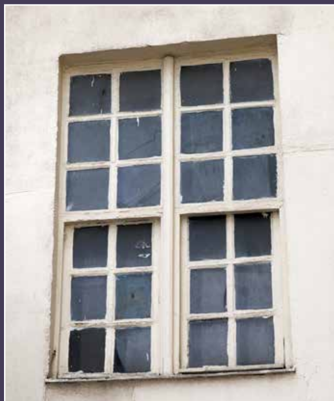
Vue d'une fenêtre du corps de bâtiment éclairant la cage d'escalier.
