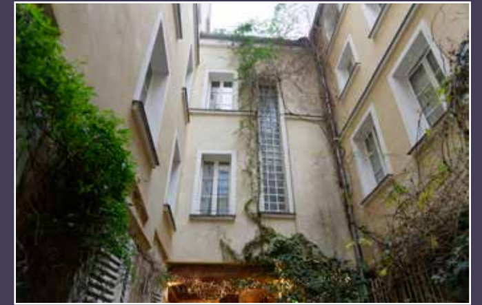
Vue du bâtiment de fond de la première cour.
