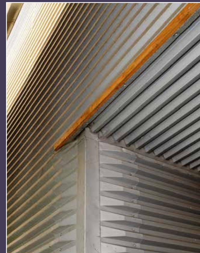
Détail de mise en oeuvre du bardage métallique.
