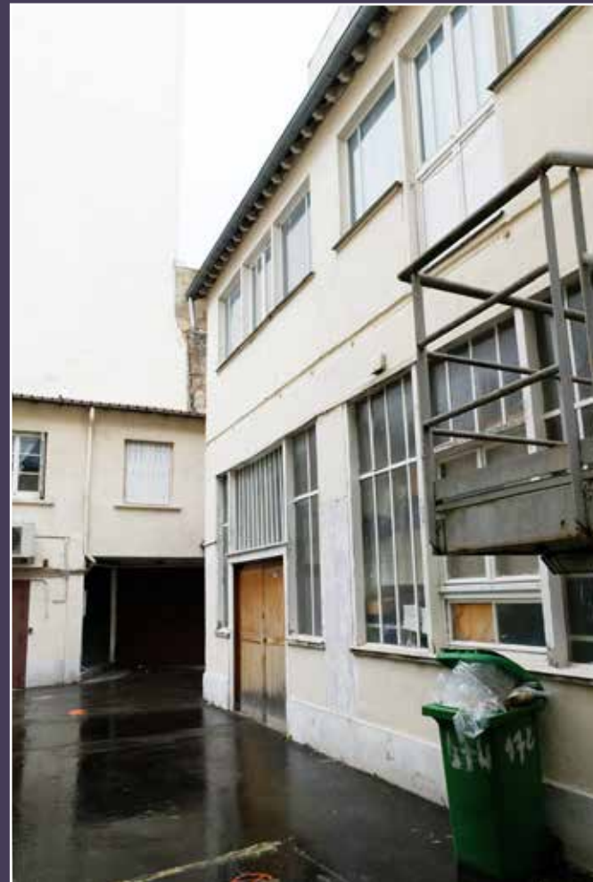
Vue actuelle du bâtiment-atelier en fond de cour et construction récente en aile à gauche.
