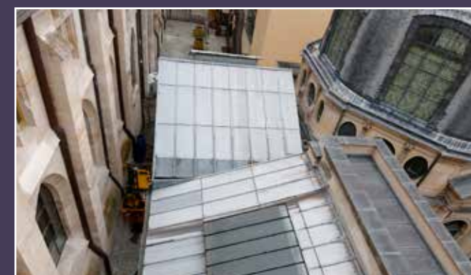
Vue du dôme et des toitures du « Bâtiment de l'Étude » qui abrite le petit amphithéâtre.
