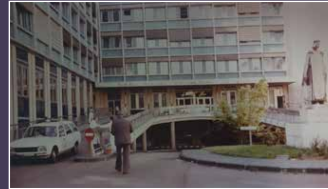
Vue de fin de chantier. L'entrée principale et sa rampe double, s.d. (Archives des Quinze-Vingts).
