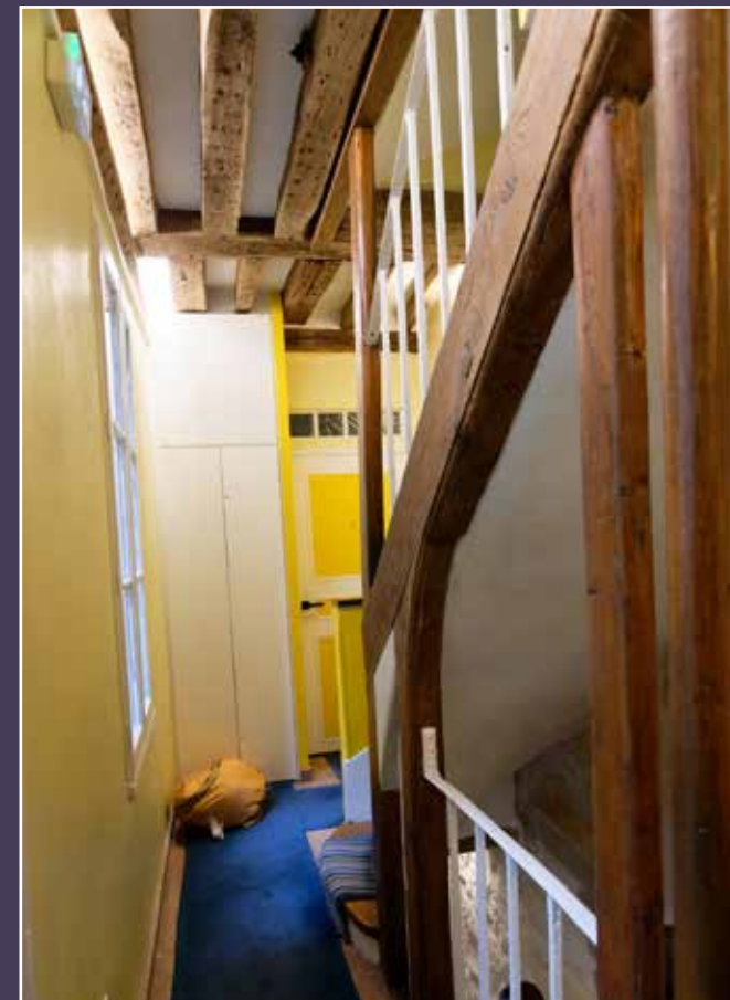
Vue actuelle de l'escalier.
