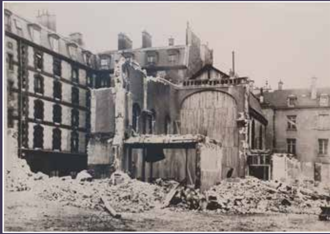
Vue de la chapelle en cours de démolition partielle, 1975 (Archives des Quinze-Vingts).
