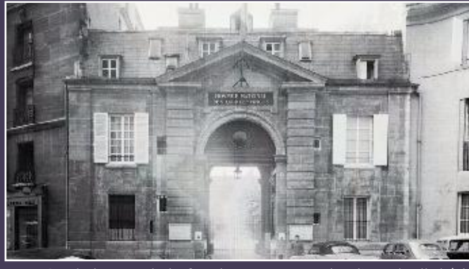
Jean Goubeix, vue de la façade sur rue, porche d'entrée dit bâtiment de la porterie, vers 1951 (Médiathèque du Patrimoine et de la Photographie).
