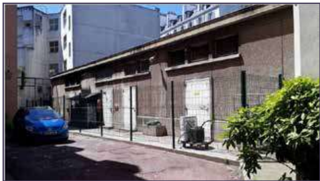
Vue actuelle l'ancienne chaufferie de l'hôpital, depuis la cour (© Wilmotte & Associés).
