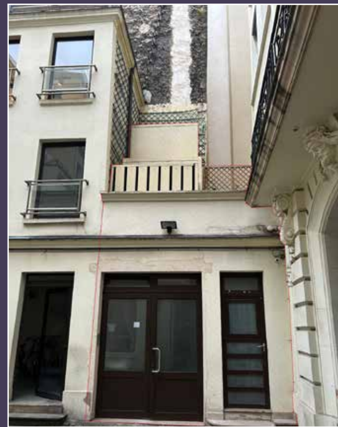
Vue actuelle de la jonction de l'aile droite avec le bâtiment sur rue, dont la démolition est demandée (© Quadri Fiori Architecture).
