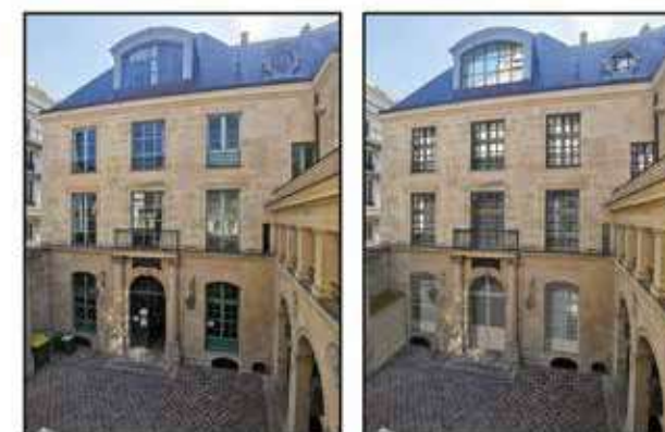
Vue sur le bâtiment de l'administration, état actuel et projet de remplacement des menuiseries (© Lympia architectes).
