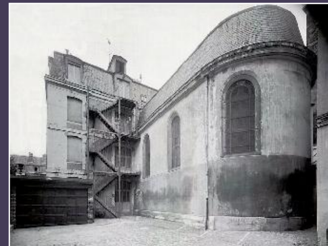
Emmanuel-Louis Mas, vue de la chapelle, 1957 (Médiathèque du Patrimoine et de la Photographie).
