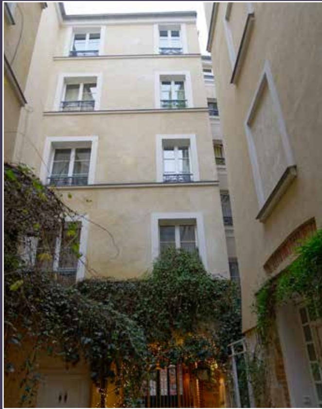
Vue actuelle du revers des bâtiments sur la rue des Gravilliers.
