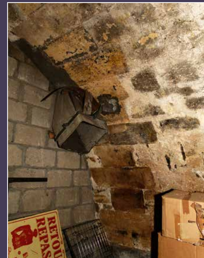
Vue des caves situées sous le corps de logis sur rue.
