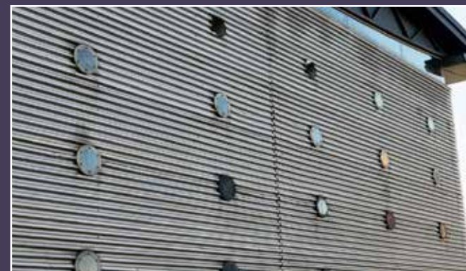
Vue de la façade ajourée d'oculi.
