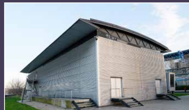
Vue du traitement de l'angle et de la couverture.
