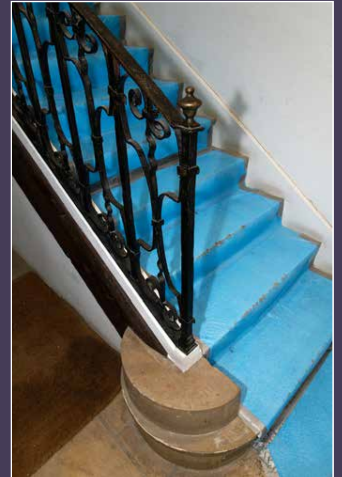
Vue actuelle de la première rampe de l'escalier du bâtiment au fond de la parcelle.
