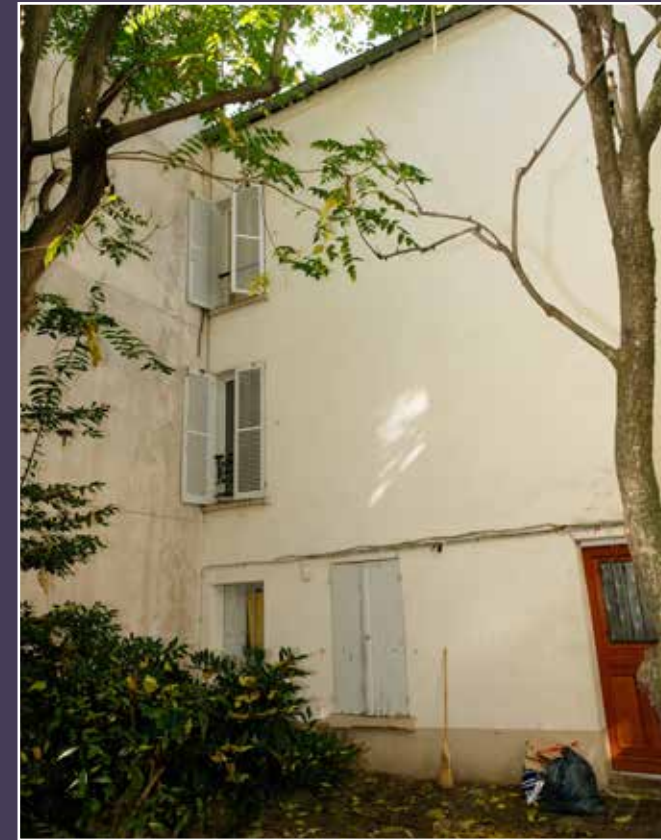
Vue du revers de la façade du bâtiment élevé sur la rue Marmontel.
