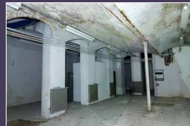
Vue actuelle des caves situées sous la cour.
