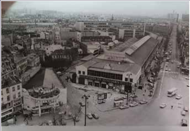
Vue depuis la place de la Bastille en direction des Quinze-Vingts. Le chantier est amorcé, mais de nombreux bâtiments subsistent, vers 1957 (Archives des Quinze-Vingts).
