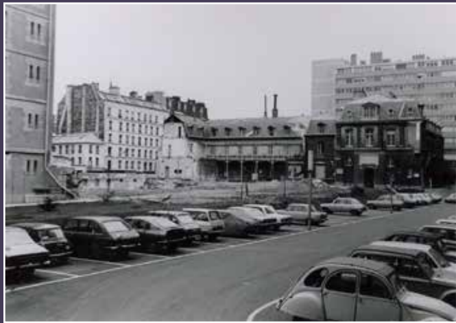
Vue de l'hôpital des Quinze-Vingts en chantier, 1976 (Médiathèque du Patrimoine et de la Photographie).
