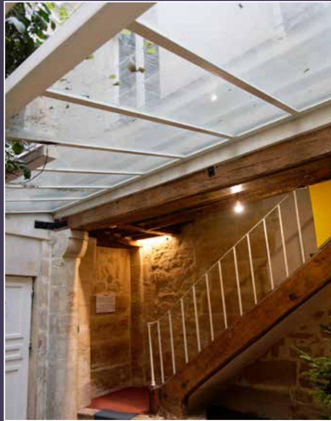
Vue du départ de l'escalier de l'ancien n° 32.
