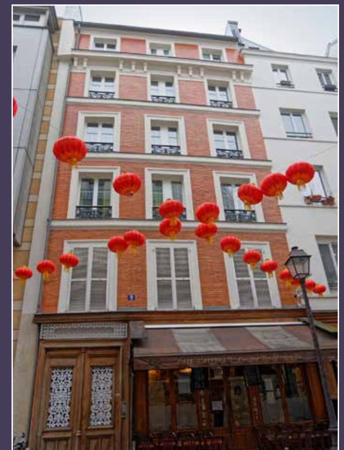
Vue actuelle de la façade sur la rue au Maire.
