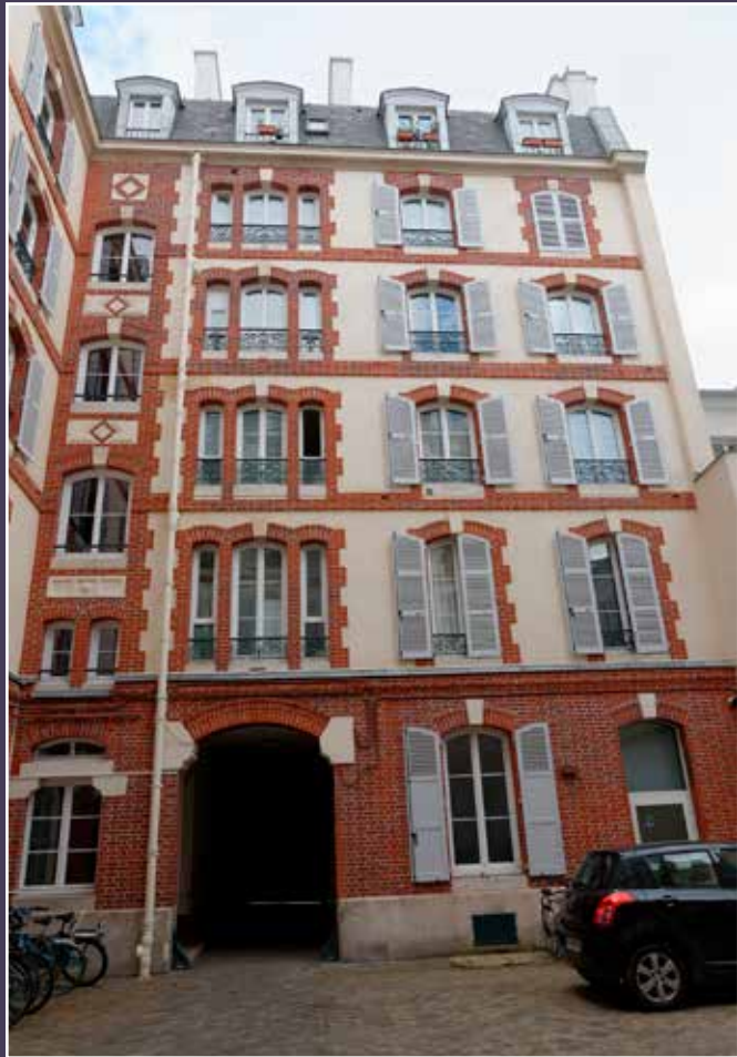
Vue actuelle des immeubles d'habitation édifiés par Juste Lisch au 24 rue de Charenton.
