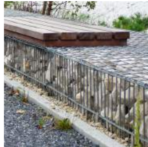
GABIONS CALCAIRE ET CAGE GALVA locaux et murets intérieurs
