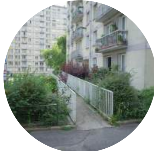
Rampe PMR à l'entrée du Bâtiment B
