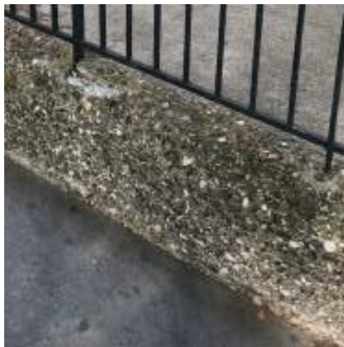
SOUBASSEMENT BÉTON GRANULAT APPARENT murs-murets extérieurs
