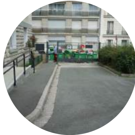
L'accueil du Bâtiment C est muni d'une rampe PMR, mais pour y accéder depuis la rue il faut gravir la pente supérieure à 5%
