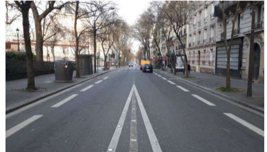
Au droit du square Edouard Vaillant : vers l'Est
