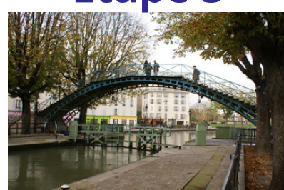
Passerelle Bichat (10e)
