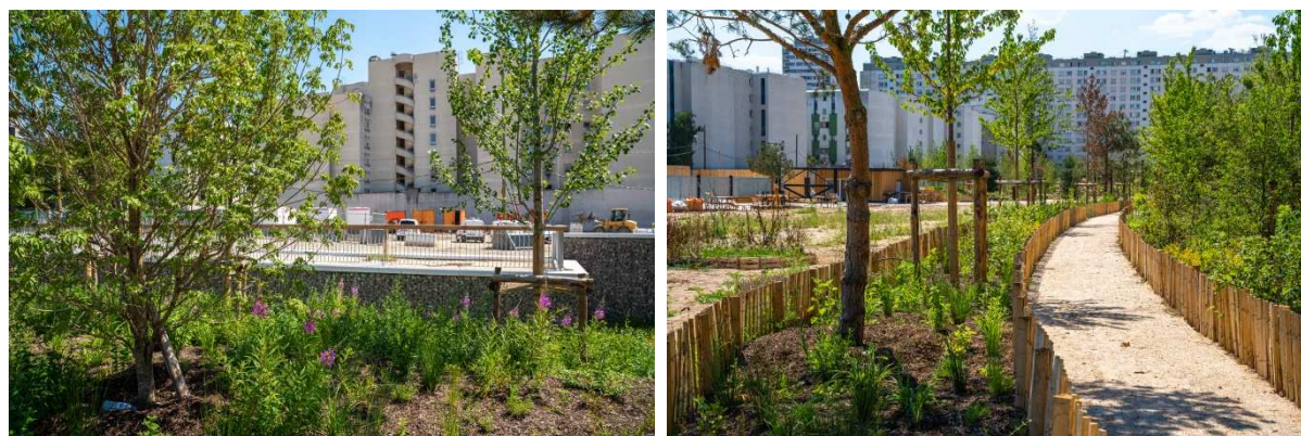
Parc Chapelle Charbon (18 e ) en chantier © Sonia Yassa / Ville de Paris
