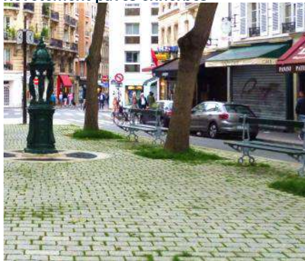
Revêtement pavés enherbés
