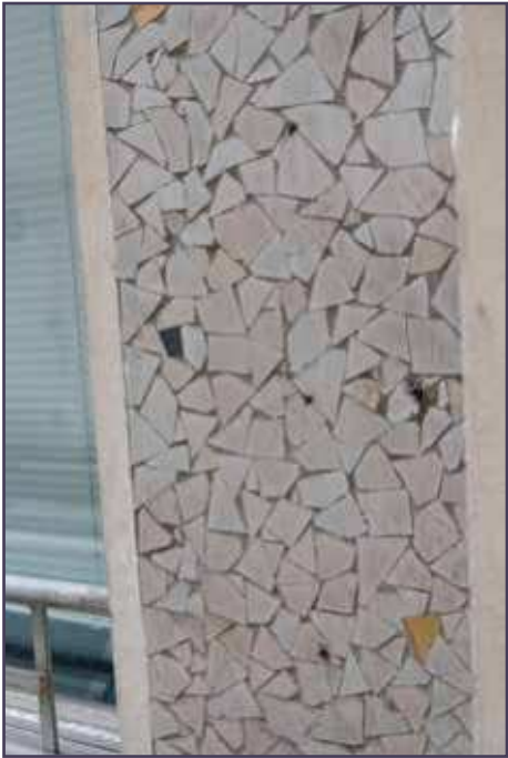
Détail du revêtement en faïence « cassée ».
