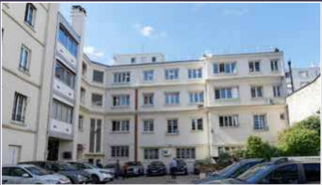
Vue des façades sur cour. Au milieu, la travée édifiée en 1965.
