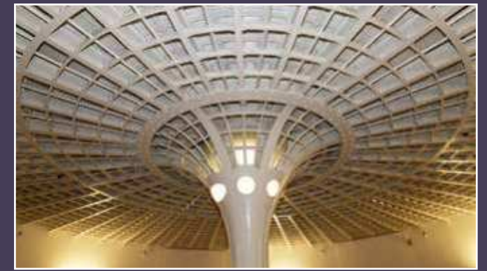
Vue actuelle de la voûte plate métallique de la salle des coffres.
