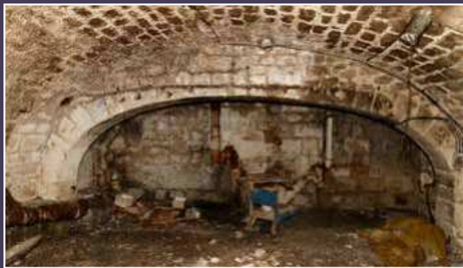
Vue actuelle des caves du 14 rue du Temple.
