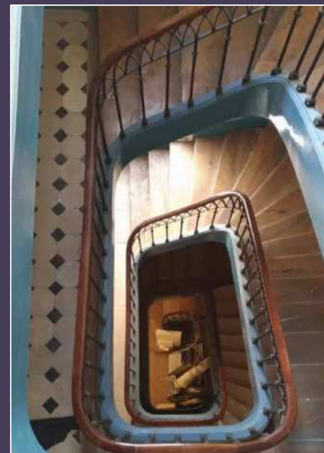
Vue actuelle de l'escalier d'origine.
