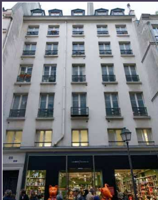
Vue actuelle de la façade sur rue du 42 rue de la Verrerie.
