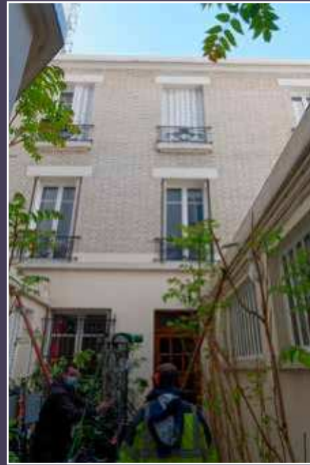
Vue actuelle du bâtiment sur cour.
