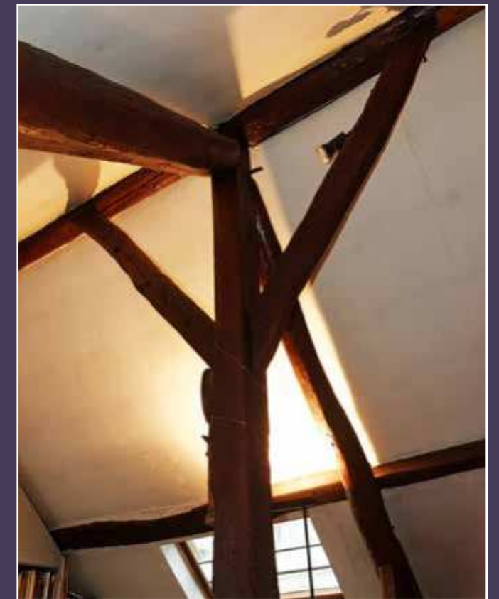
Vue actuelle de la charpente de la maison sur rue.
