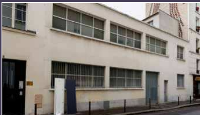
Vue de l'immeuble sur la rue Dahomey construit en 1964 et voué à la démolition, 2016.
