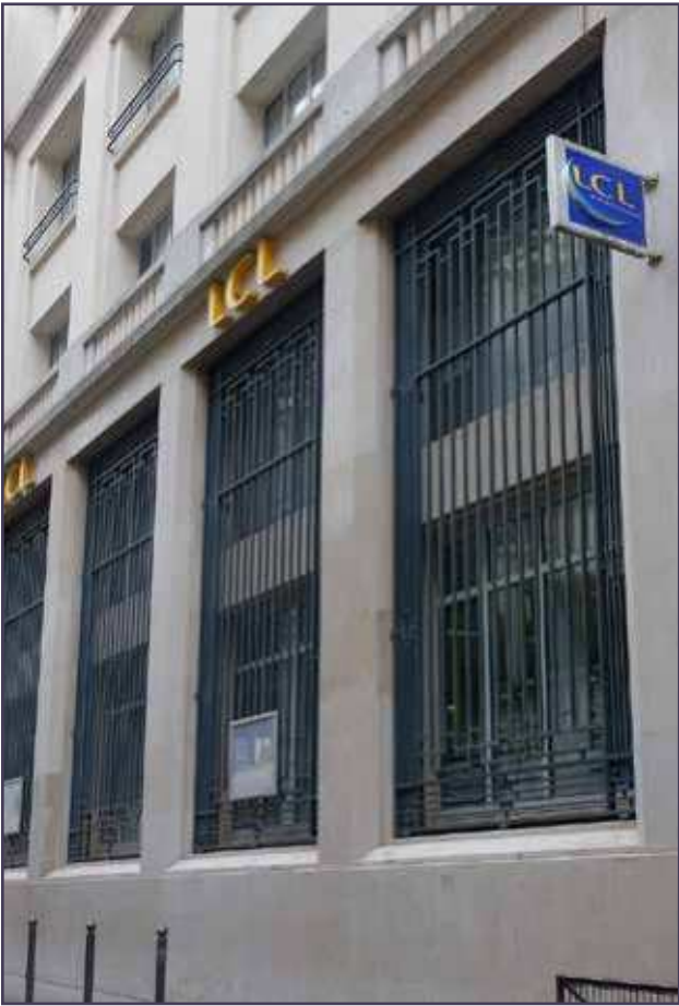
Détail de la façade donnant sur la rue Feydeau.
