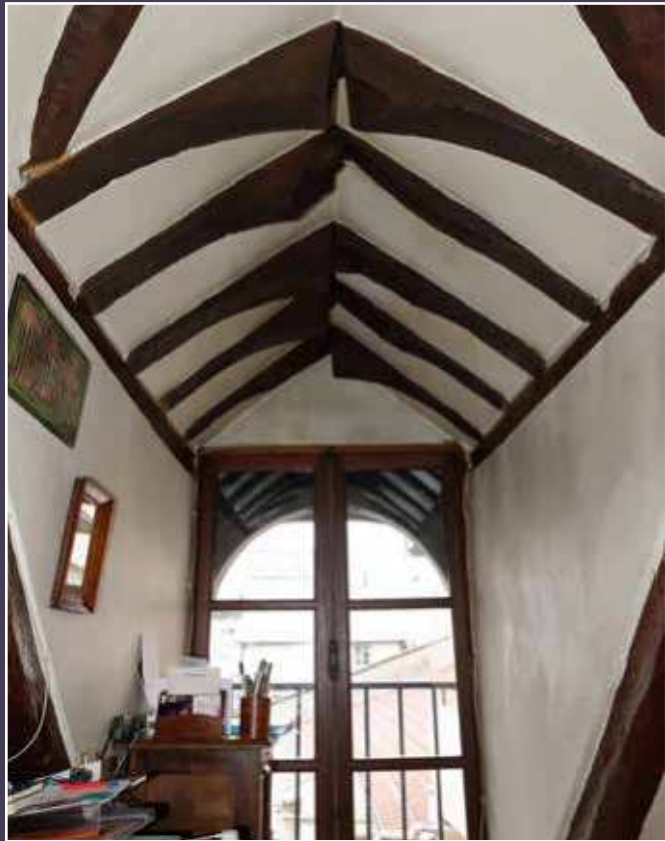
Détail de la charpente de la lucarne.
