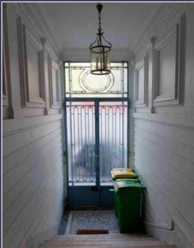
Vue intérieure de la porte d'entrée à ferronnerie.
