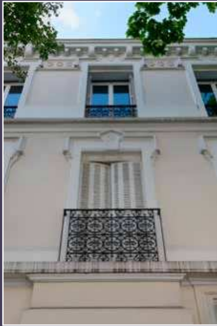
Détail de la façade sur rue, vue actuelle.
