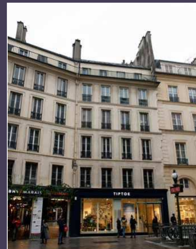
Vue actuelle de la façade sur rue du 14 rue du Temple.
