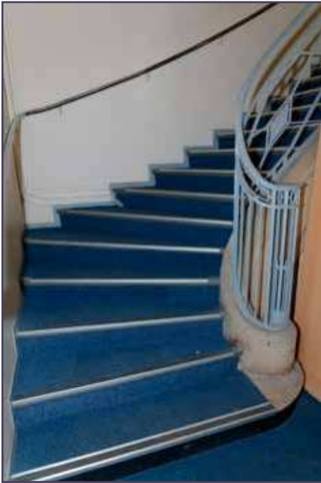
Vue actuelle de l'escalier qui mène au sous-sol.
