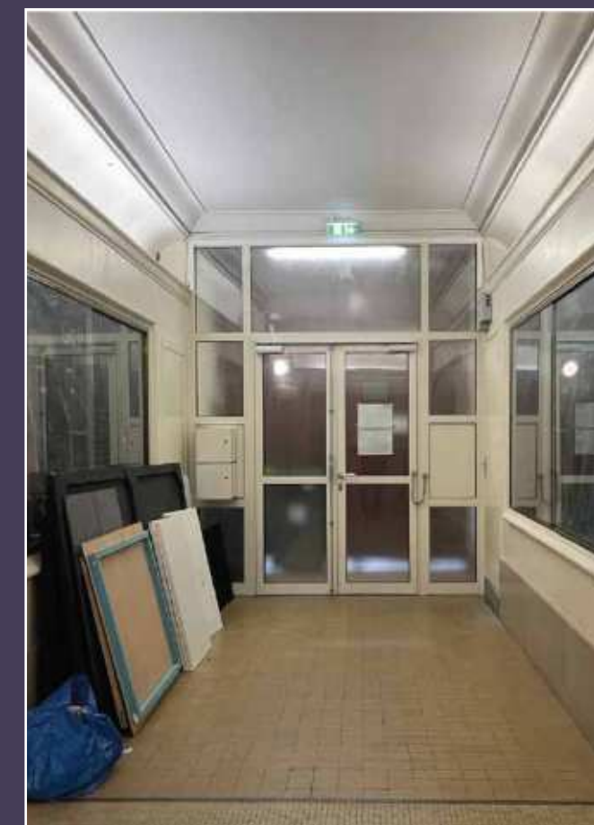
Vue actuelle du hall d'entrée.
