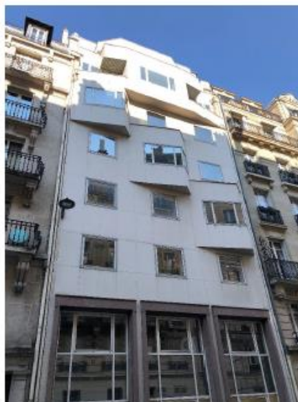
Les antennes ne sont pas visibles depuis la rue
