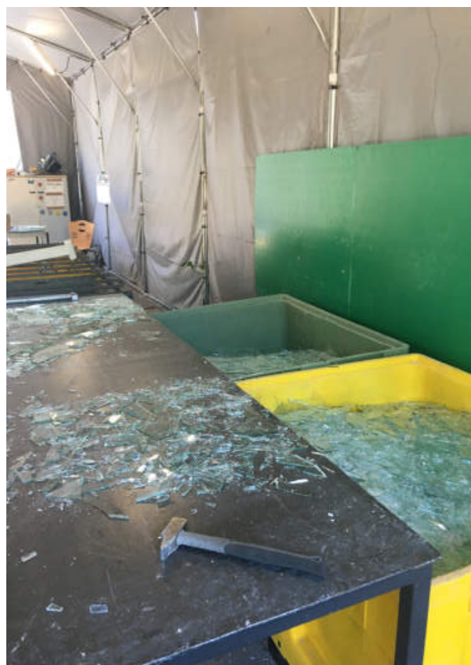
Mise en place du recyclage des fenêtres
