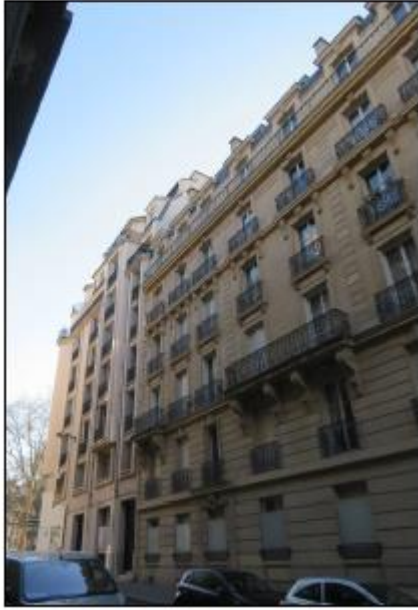
État de l'immeuble :
