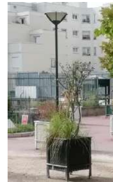
Candélabres existants (fûts VP95, H=4m=) maintenus dans le cadre du projet
