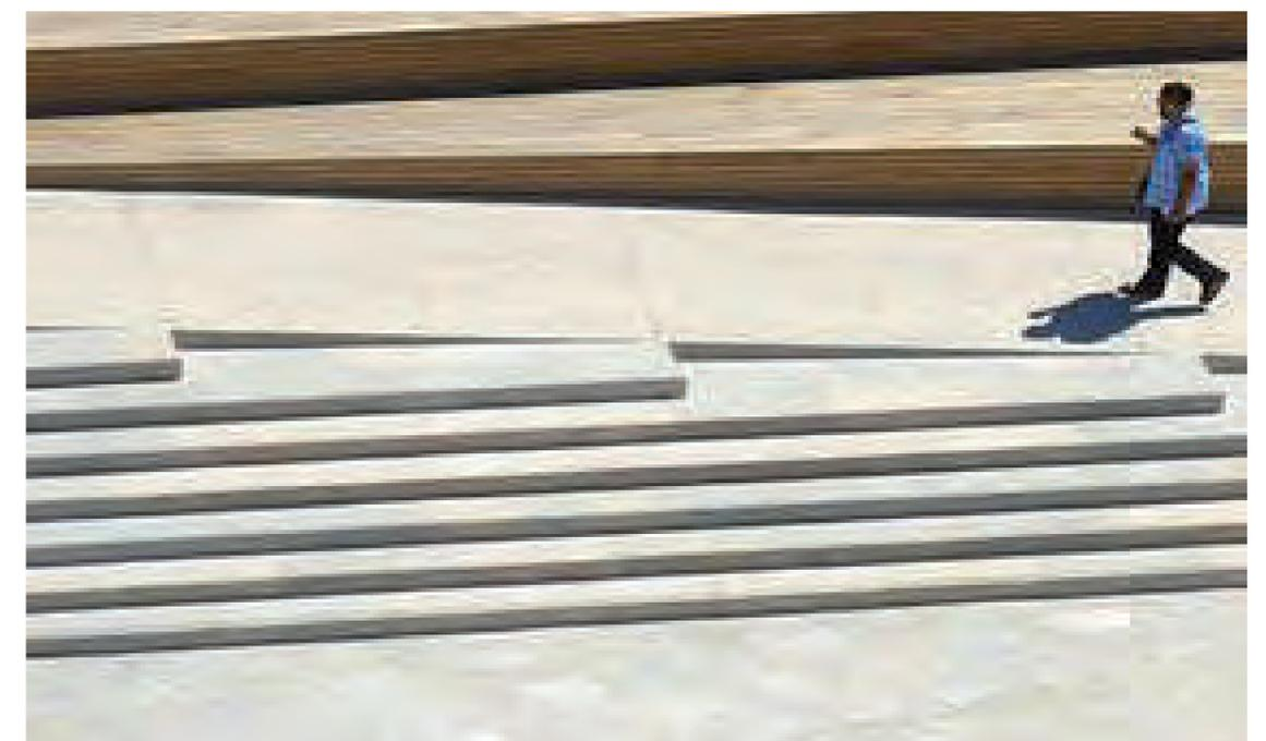
Exemple de gradinage associé à une rampe
