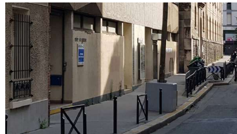
Seuils réhaussés du gymnase
