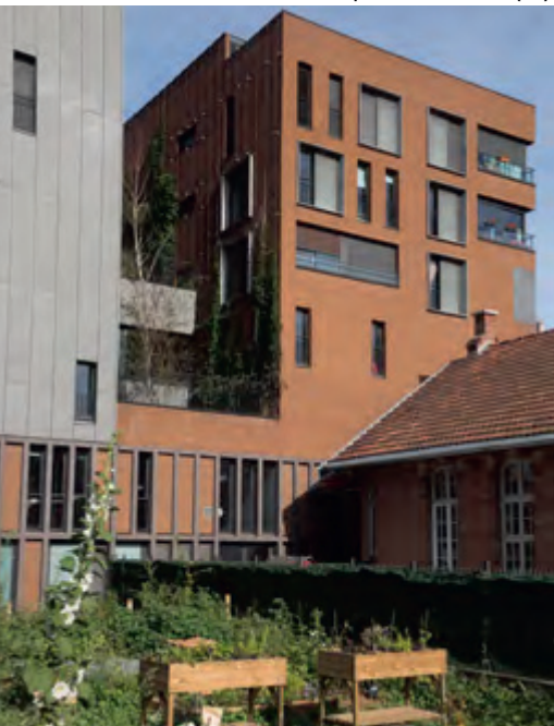
Écoquartier Boucicaut (15 e ).
