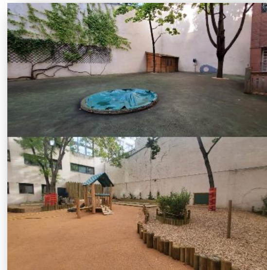
L'avant et l'après des travaux de la cour oasis de la crèche collective Bassompierre (4 e ) © D.R.
