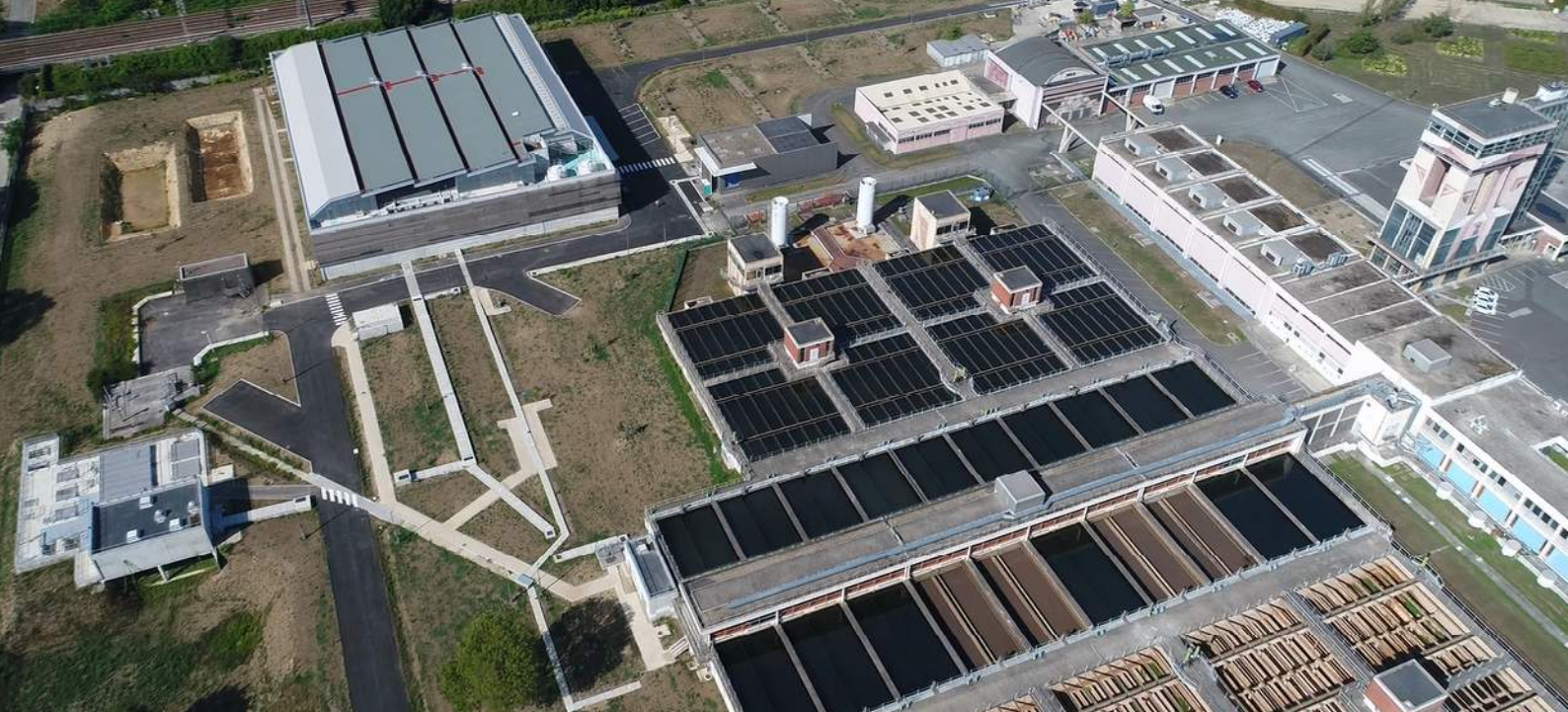
Prise de vue par Drone de la filière Orly II (août 2022)
