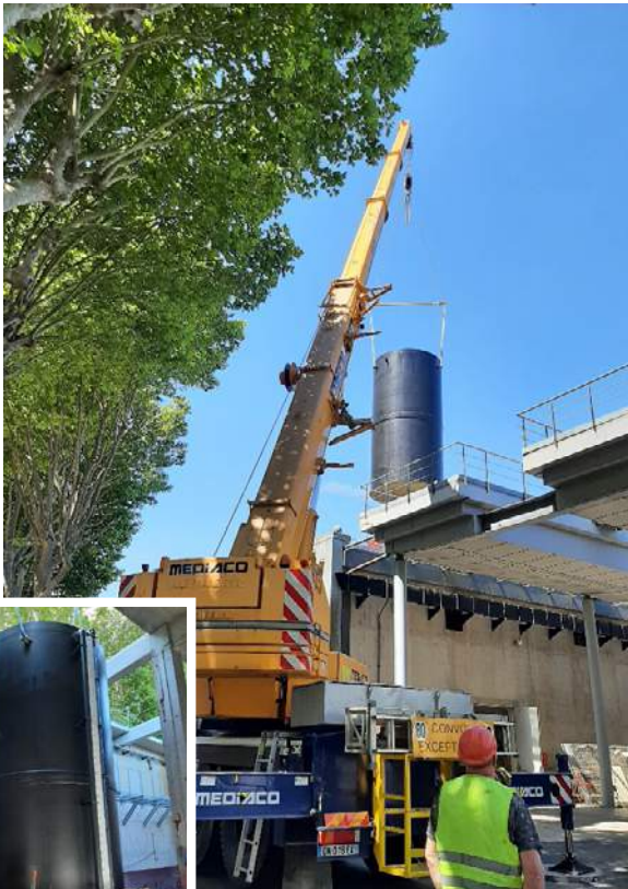
Manutention et insertion de la cuve n°1 dans sa rétention
