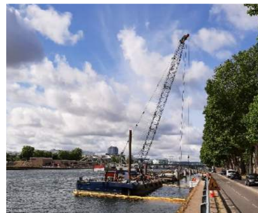
Obturation de la prise d'eau en Seine (via des scaphandriers)
