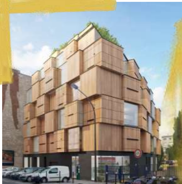
Future boutique solidaire en pied d'immeuble de l'annexe 42
