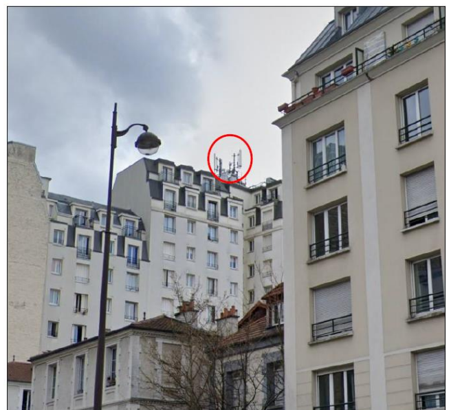
Etat projeté : pas de modification visuelle
