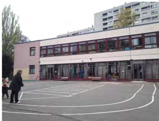
Photo 2 : Préau côté Sud de l'école maternelle
