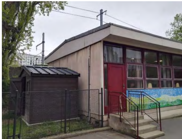
Photo 1 : Bâtiment de préfabriqué accueillant deux classes de maternelle
