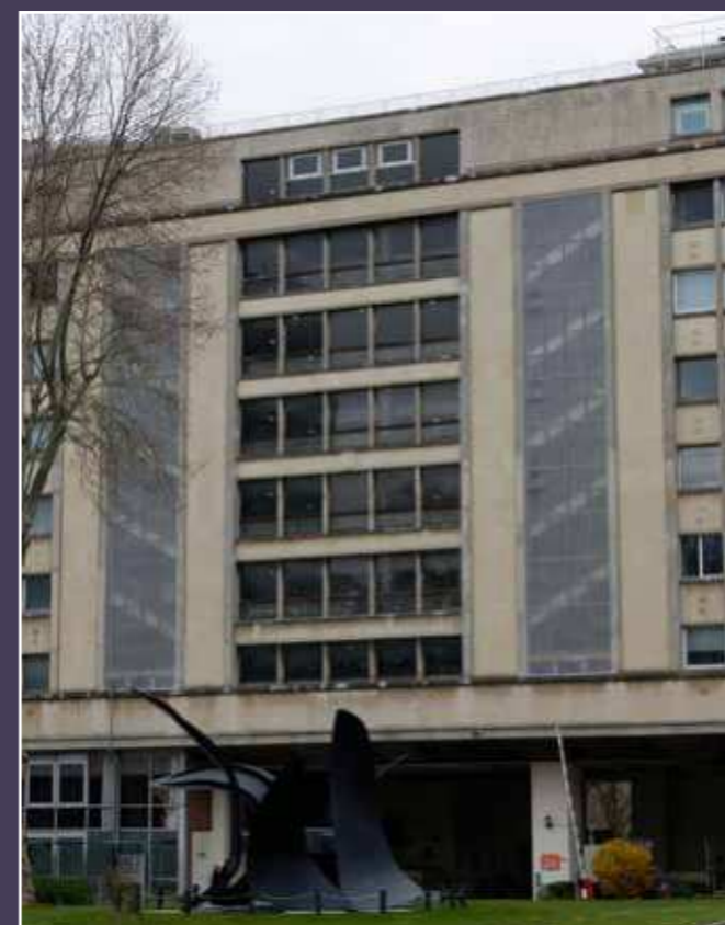
Vue actuelle, depuis le campus, des travées de l'escalier d'honneur qui seraient modifiées.
