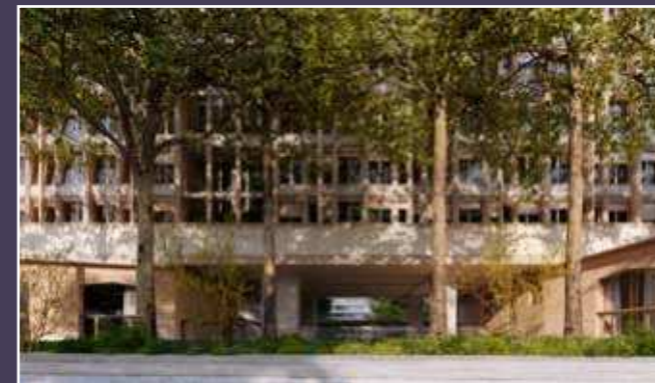
Vue rapprochée sur la rue Cuvier et l'un des porches recréés au rez-de-chaussée (© Charles-Henri Tachon architecture).
