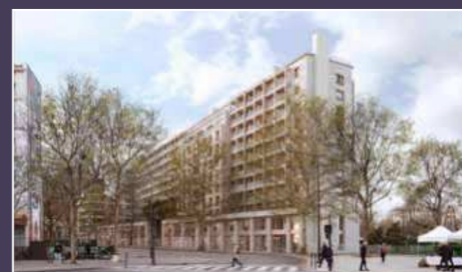
Vue d'insertion, depuis la place de la porte de Vanves, du bâtiment restructuré et des traitements différenciés en façade (© MG-AU / JBMN architectes).
