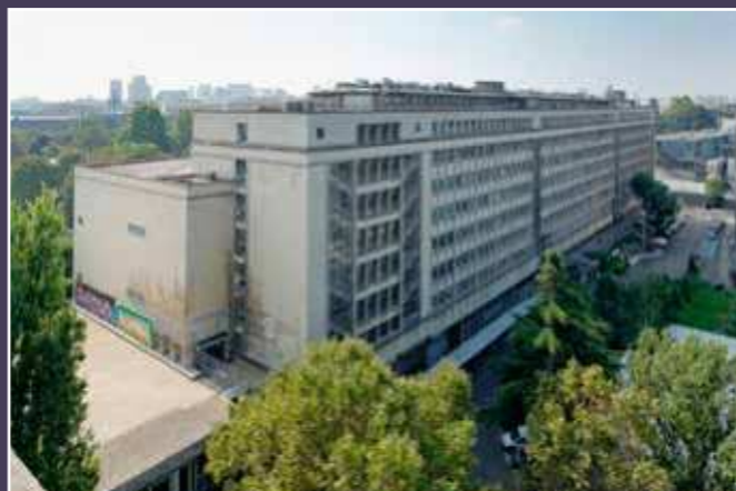
Vue de la barre prise depuis sa jumelle alignée le long du quai, 2016 (© Christian Rapa).
