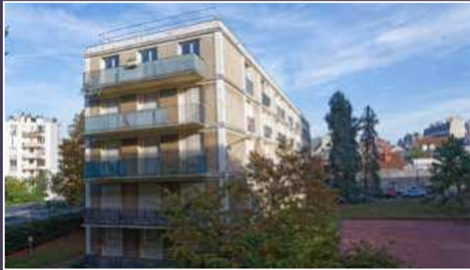
Vue actuelle du bâtiment B et de ses balcons.
