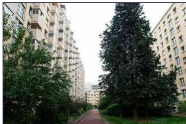
Vue des bâtiments B1 et B2 (à gauche) et A1 (dans le fond).
