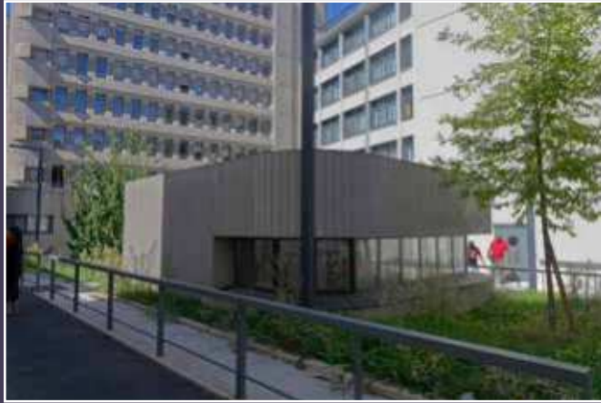
Vue actuelle du pavillon d'entrée voué à la démolition.
