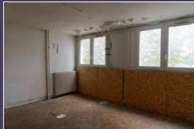
Vue du revers d'une façade.
