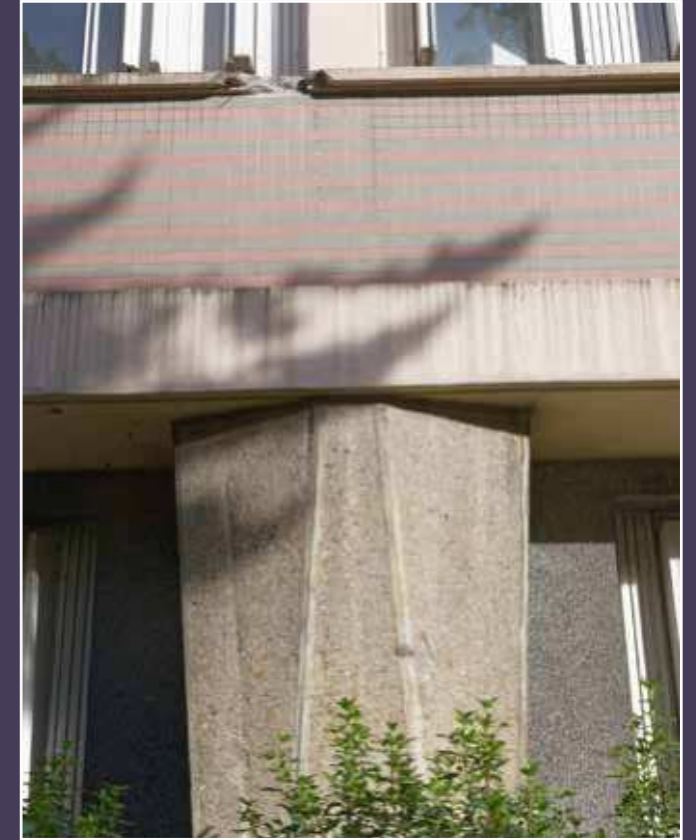
Détail de la façade du bâtiment C.
