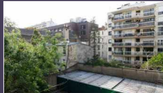
Vue actuelle du fond de la parcelle avec les boxes.
