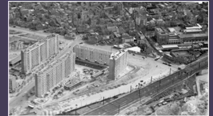
Vue aérienne de l'opération de la Porte de Vanves, 1956 (© IGN).
