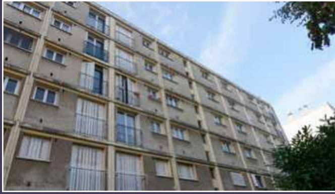
Vue actuelle des bâtiments A-A' promis à la démolition.
