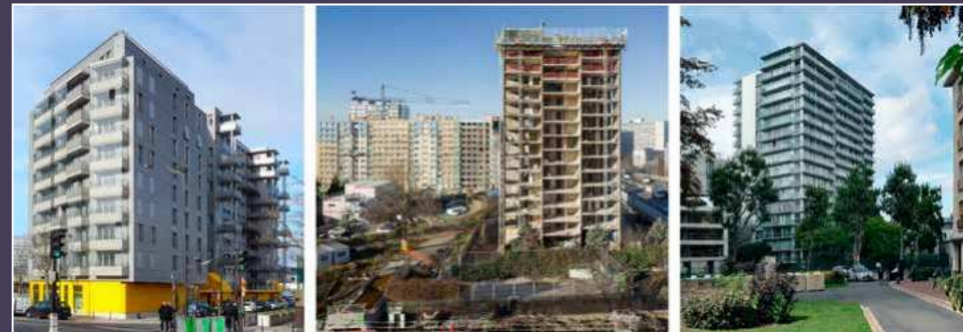
De gauche à droite : la barre Borel rénovée, la tour Borel démolie, la tour Bois-le-Prêtre rénovée (© Documentation AUC).
