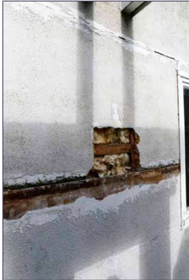
Dégradation laissant voir le mode constructif de l'immeuble sur rue.
