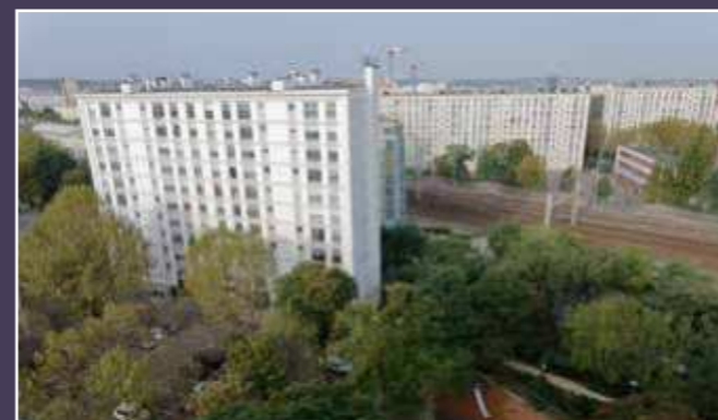
Vue actuelle de la barre dont la restructuration est demandée avec, au premier plan, l'espace vert existant et les stationnements.
