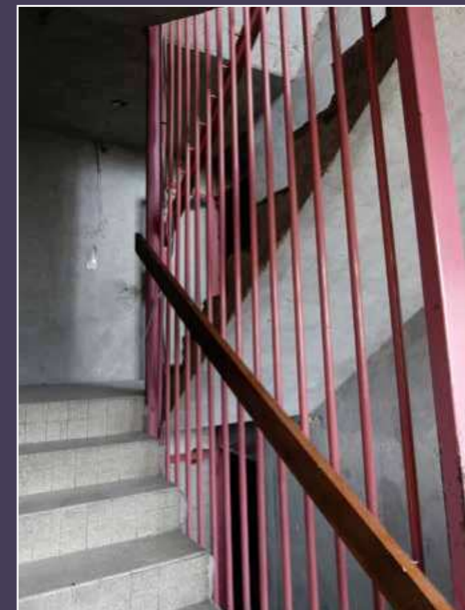
Vue d'une des deux cages d'escalier qui seront conservées.
