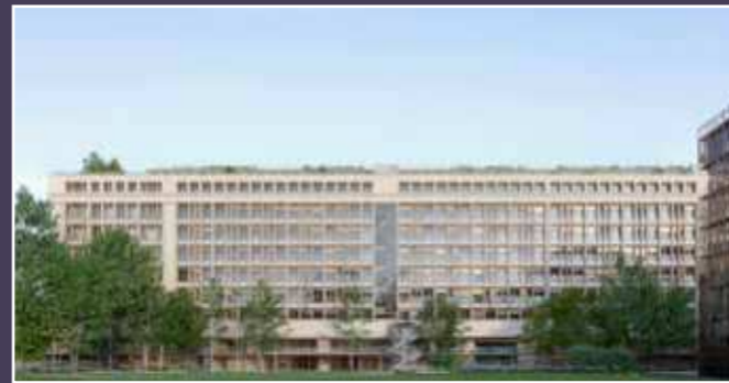
Vue d'insertion depuis le campus de Jussieu. À droite, les travées de l'escalier d'honneur redessinées. Au rez-de-chaussée, la cour-sive dont la création est demandée (© C.-H. Tachon arch.).
