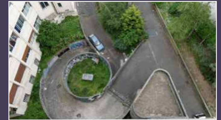
Vue de la rampe avant la réhabilitation de l'ensemble, 2015.
