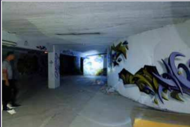
Vue actuelle d'un niveau de sous-sols.
