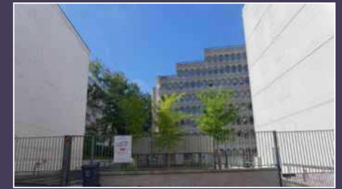
Vue actuelle de l'ensemble réhabilité, depuis la rue de l'Inspecteur Allès.
