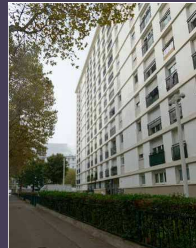
Vue actuelle de la façade de la barre le long de l'avenue de la porte de Vanves.
