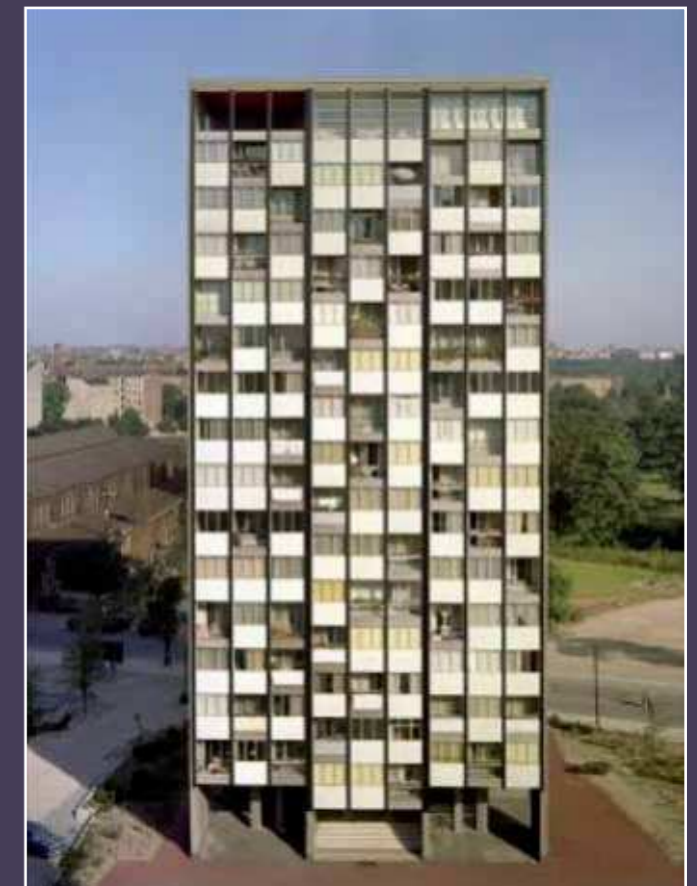
La Tour Bartningallee à Hanaviertel-Berlin (© Documentation AUC).
