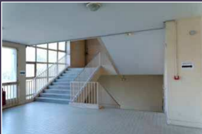
Vue d'un palier de l'escalier d'honneur dont la démolition est demandée, 2016 (© Christian Rapa).
