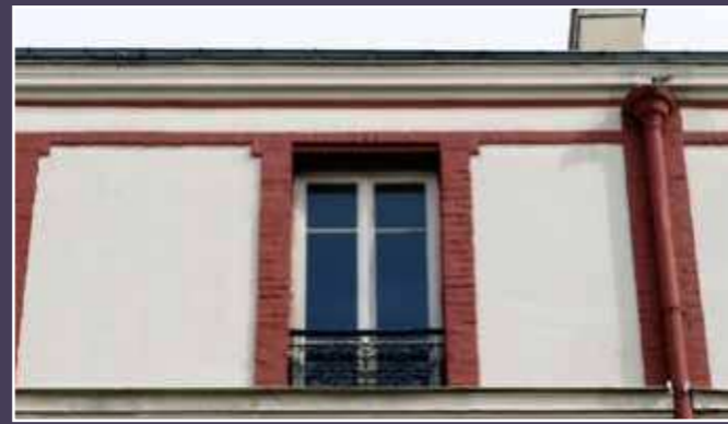
Détail de la façade arrière.
