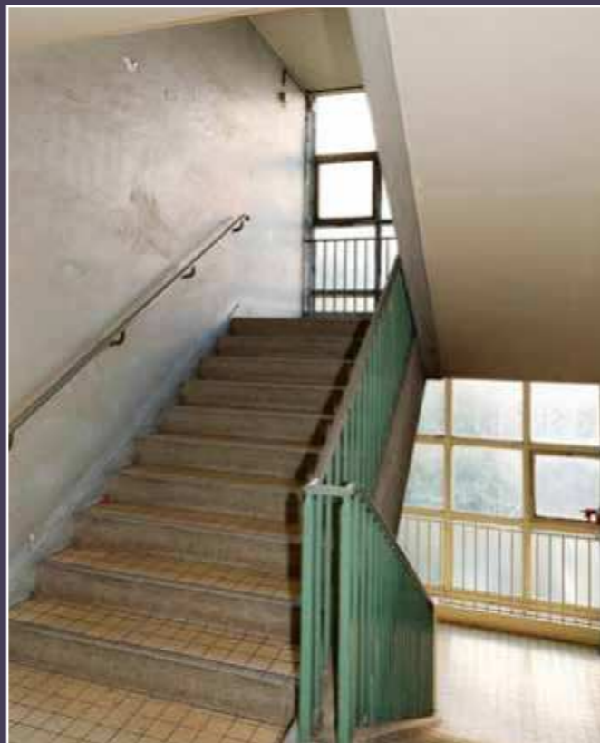
Vue de l'escalier secondaire dont la démolition est demandée, 2016 (© Christian Rapa).
