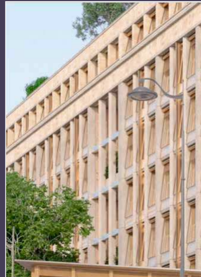
Détail du traitement des ouvertures des étages courants avec stores et garde-corps inclinés (© Charles-Henri Tachon architecture).
