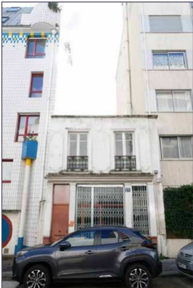
Vue actuelle de la maison-atelier depuis la rue.
