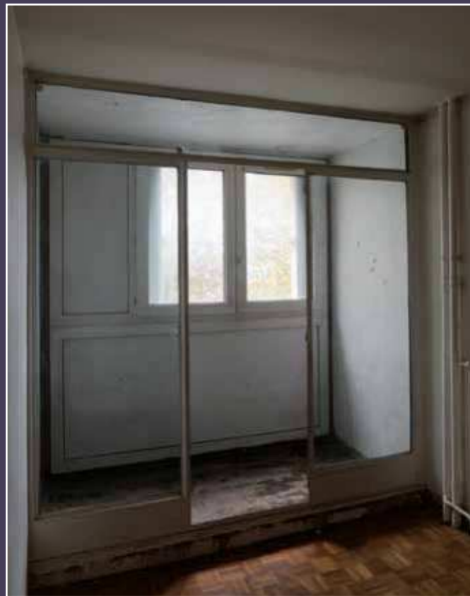
Vue d'une ancienne loggia fermée.
