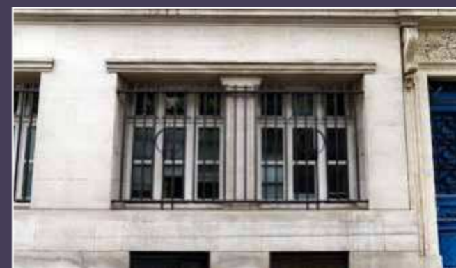
Vue actuelle du rez-de-chaussée, modifié après l'extension des bureaux au 5 avenue Victoria.
