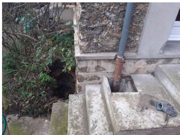
Débouffage d'un ancien puits sous les fondations d'un pavillon à Arcueil, à proximité d'une descente d'eau fuyarde
