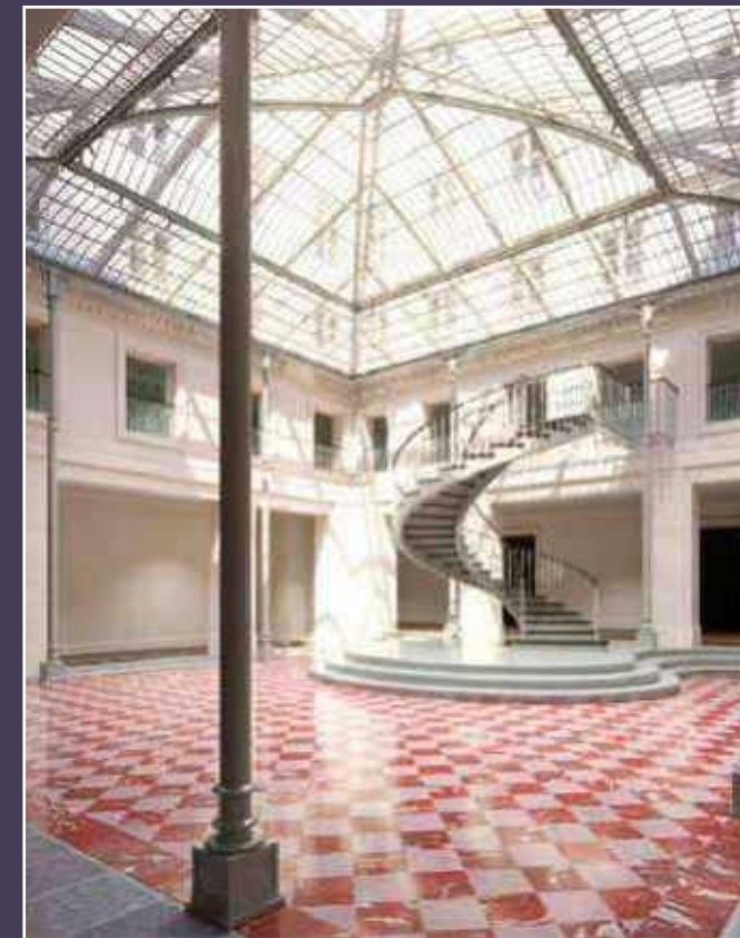
Perspective de la cour réaménagée avec escalier monumental entraînant la dépose de deux allèges (© Franklin Azzi architecture).
