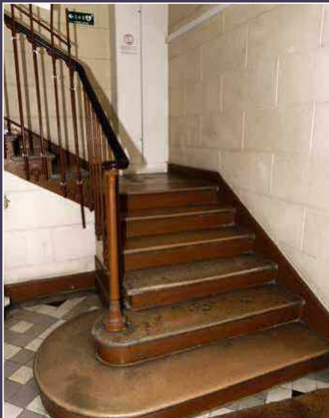
Vue actuelle de la première rampe de l'escalier principal.
