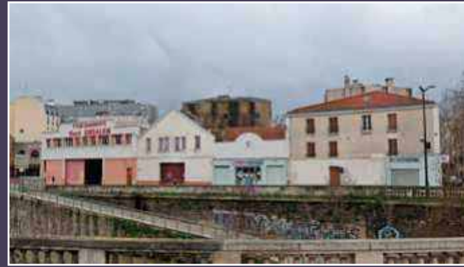
Émergence de l'ancienne imprimerie désaffectée depuis le quai.
