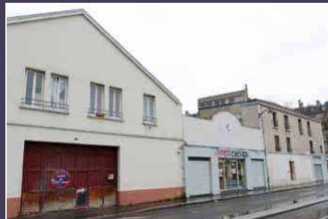
Vue, depuis le quai, de la halle dont la surélévation est envisagée. À gauche, le supermarché dont la démolition est prévue.
