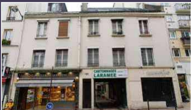
Vue rapprochée de la maison depuis la rue.
