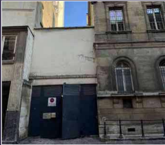
Vue actuelle du volume construit dans l'interstice au sud de la parcelle, entre les numéros 7 et 9, rue de la Banque (© GRAHAL).
