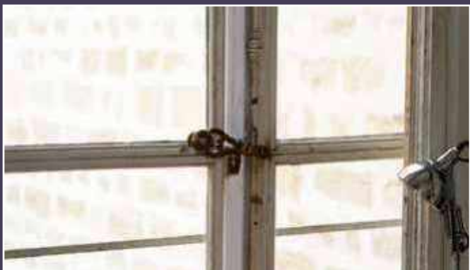
Détail d'une poignée de la menuiserie au premier étage.
