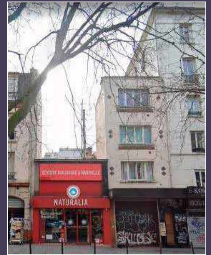
Vue des deux bâtiments de l'avenue Corentin Cariou qui seraient démolis. À droite, celui qui présente quelques ornements.
