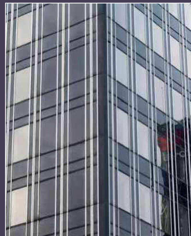
Vue de détail d'une façade d'une des tours Gamma et de sa trame écossaise.
