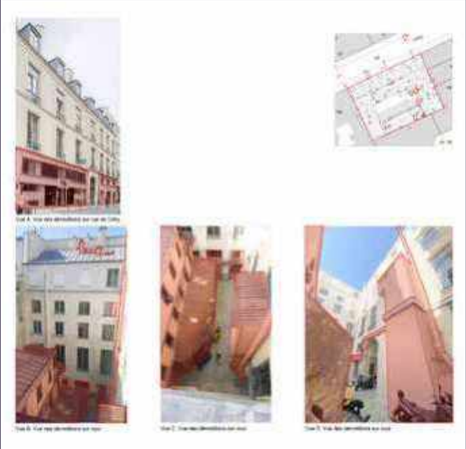
Photographies des démolitions (© Moatti-Rivière).
