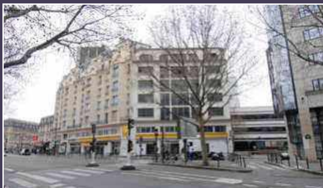
Vue du bâtiment socle en 2008.
