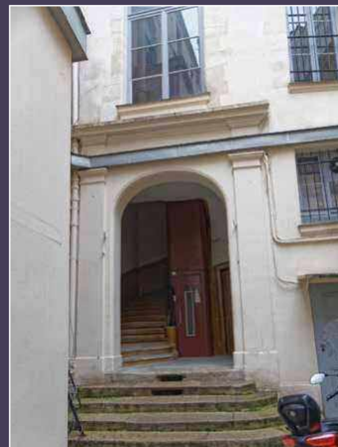
Vue actuelle du perron qui donne accès à l'escalier principal.
