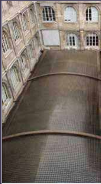
Vue actuelle de la voûte en béton et pavés de verre au-dessus de la cour de l'immeuble au n° 11 (© GRAHAL).
