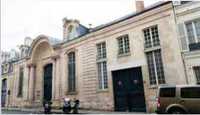
Vue actuelle de la façade sur rue.
