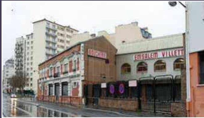
Vue rapprochée du bâtiment de bureaux protégé au titre du PLU et de la halle attenante.
