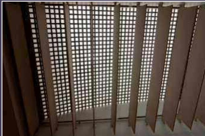
Détail de la voûte en pavés de verre depuis l'intérieur.
