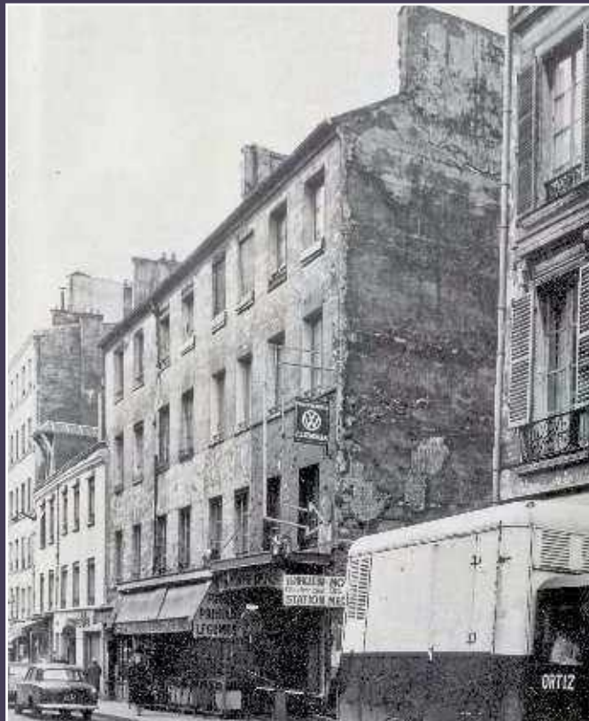
Vue de la rue de Charonne avant la construction de l'immeuble des années 1970. Au second plan, la maison du 121 (Casier archéologique).
