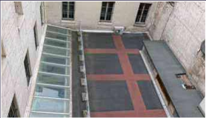
Vue actuelle de la couverture de la cour de l'immeuble au numéro 9.
