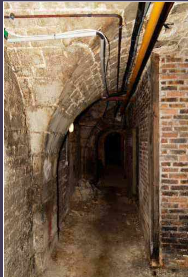
Vue actuelle du sous-sol voûté de l'aile, dans sa partie devenue un passage par un cloisonnement en brique.
