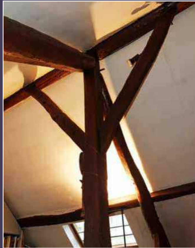
Vue actuelle de la charpente de la maison sur rue.
