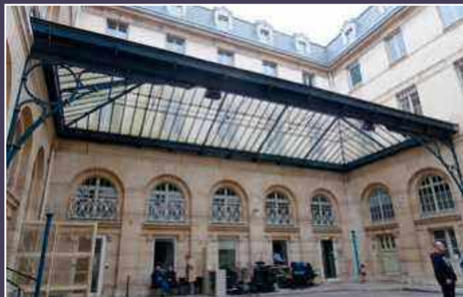
Vue actuelle de la cour au numéro 13 avec la marquise métallique.
