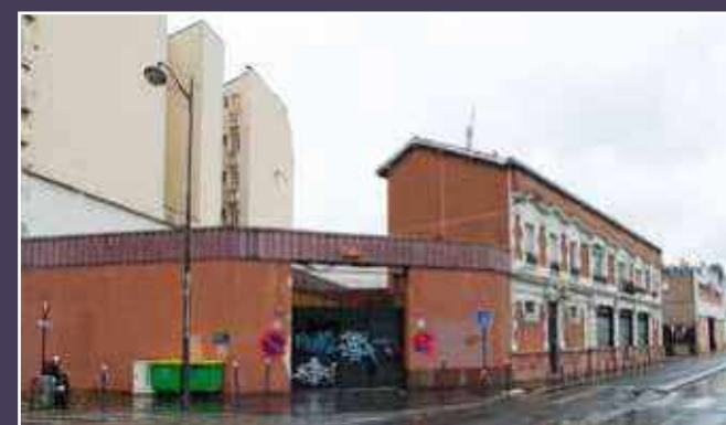
Vue à l'angle du quai et de la rue Dampierre.
