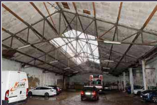
Vue intérieure de la halle attenante au bâtiment de bureaux.
