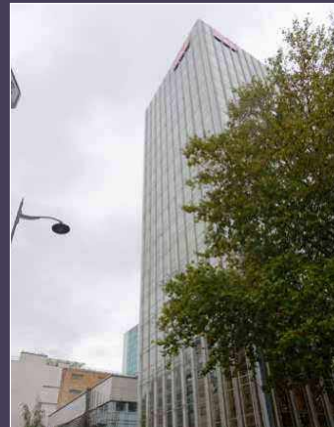
Vue actuelle de la tour de la rue Traversière. À gauche, l'entrée par le bâtiment-socle.
