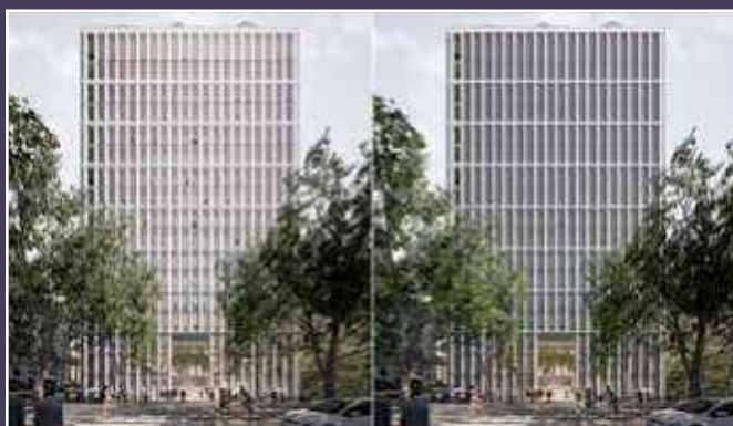
Vues d'insertion sur le quai avec la nouvelle entrée. À gauche, les stores sont ouverts, à droite ils sont fermés (© Sisto studios).
