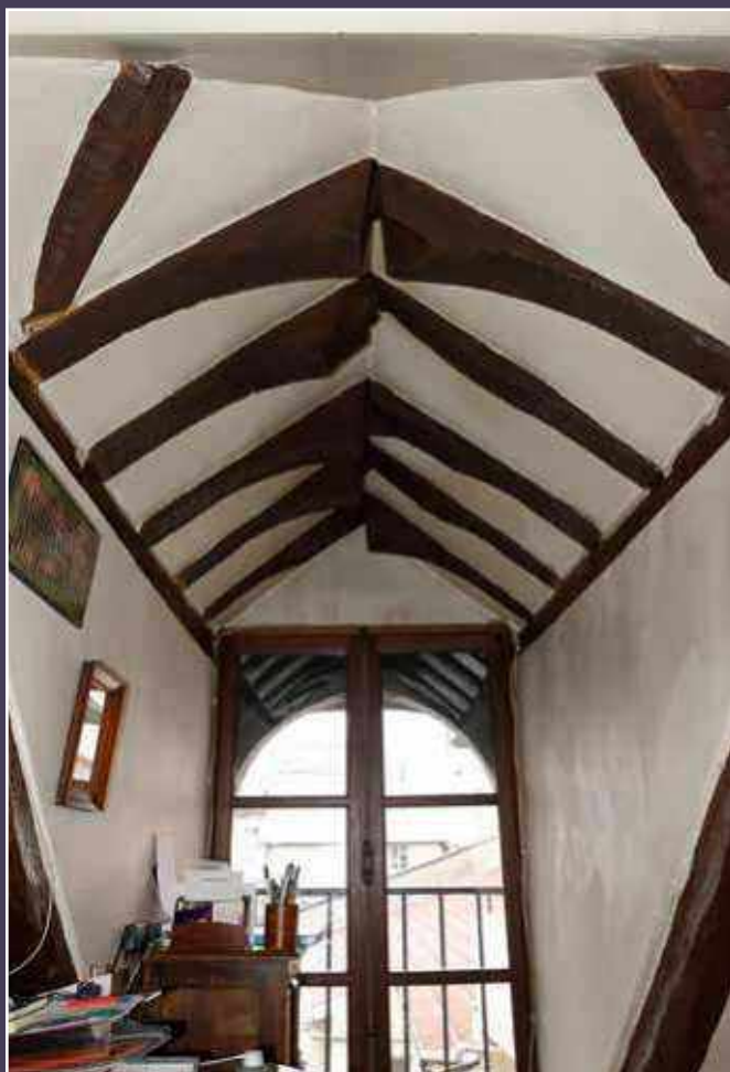
Détail de la charpente de la lucarne.
