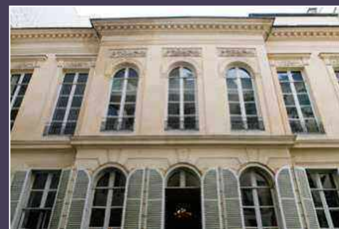
Vue actuelle des travées centrales de la façade donnant sur le jardin.
