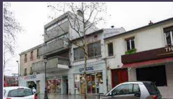
Vue des bâtiments de l'avenue Corentin Cariou qui seront démolis pour la construction d'un groupe de logements.
