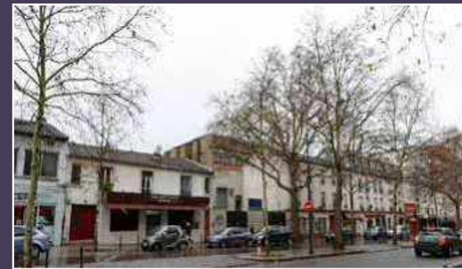
Vue de la maison dont la démolition est envisagée. À gauche, le bâtiment qui serait surélevé et épaissi.
