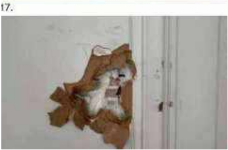
Vue de l'entresol et sondage d'une cloison, 2023 (© A-C. PERROT & F. RICHARD architectes).
