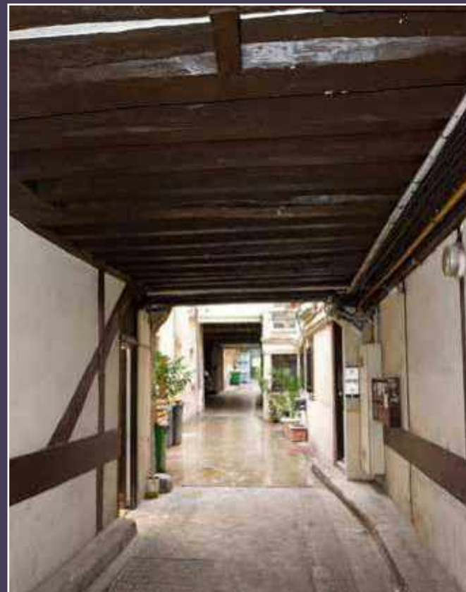
Vue actuelle du porche d'entrée avec vue sur la première cour.
