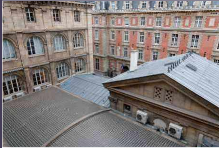
Vue actuelle de la voûte en béton et pavés de verre et du pavillon d'entrée au numéro 11.
