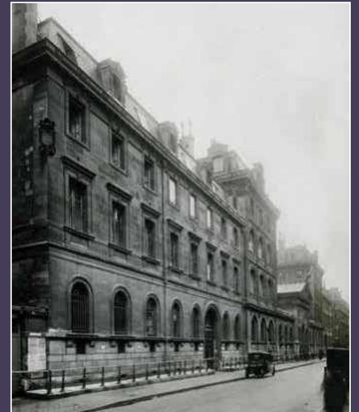
Charles Lansiaux, façade rue de la Banque, 1916 (archives de la CVP).
