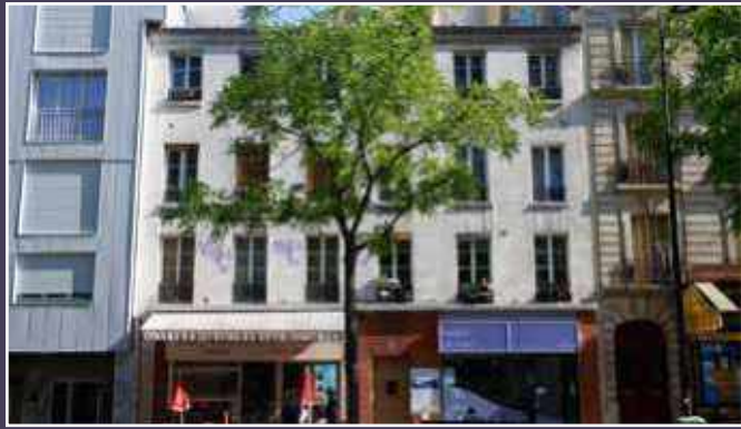
Vue sur rue de l'immeuble édifié dans les années 1840.
