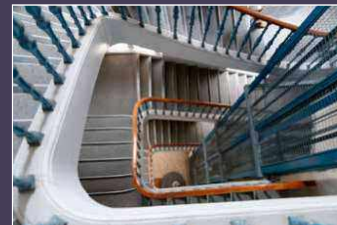
Vue actuelle de l'escalier principal de l'immeuble au numéro 13.
