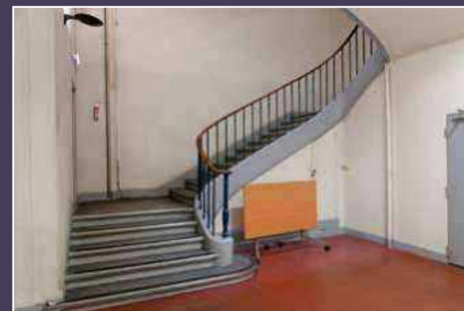
Vue actuelle de l'escalier principal de l'immeuble au numéro 11.
