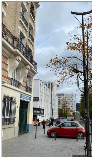
État de l'existant :
