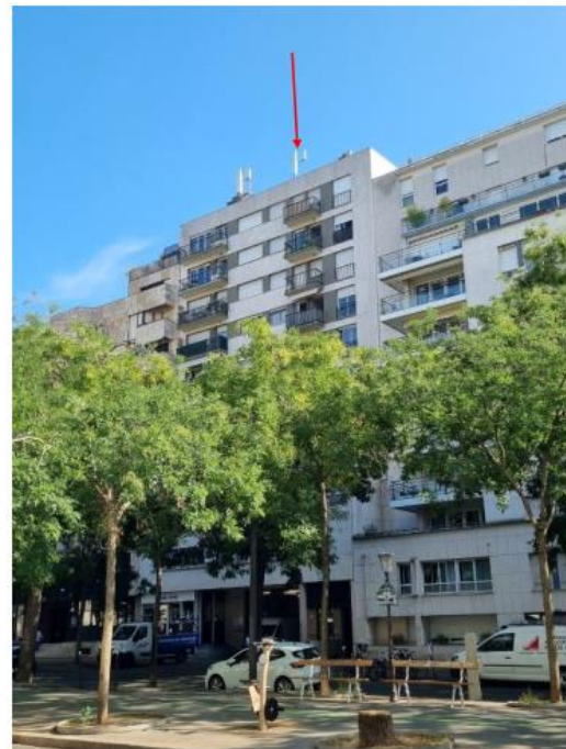
PHOTO / Après travaux
