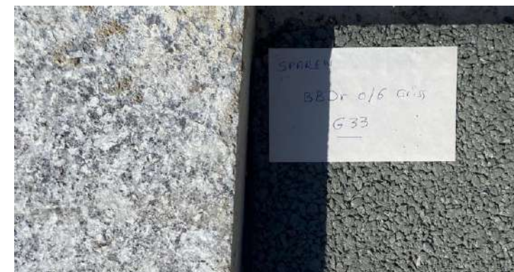
Enrobé gris (rue aux écoles Louvois)
