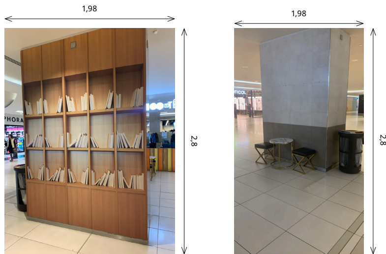
MUR 1 (des deux cotes)
