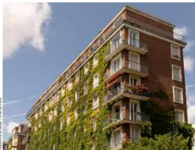
Façade végétalisée d'un immeuble (13°).
