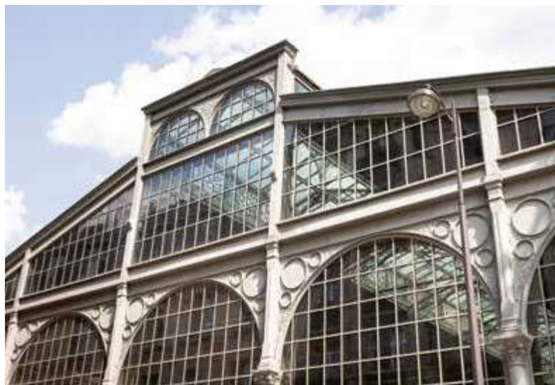
Sa structure métallique et sa façade vitrée en font un joyau patrimonial ouvert sur la ville.
