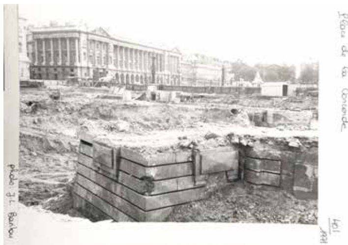
23b. Vue du chantier et d'un socle de guérite, 1971 – CVP
