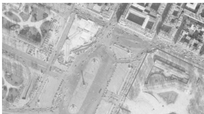
23a. Vue aérienne avec le parc de stationnement souterrain en cours de réalisation, 15 mars 1972 – Géoportail-IGN
