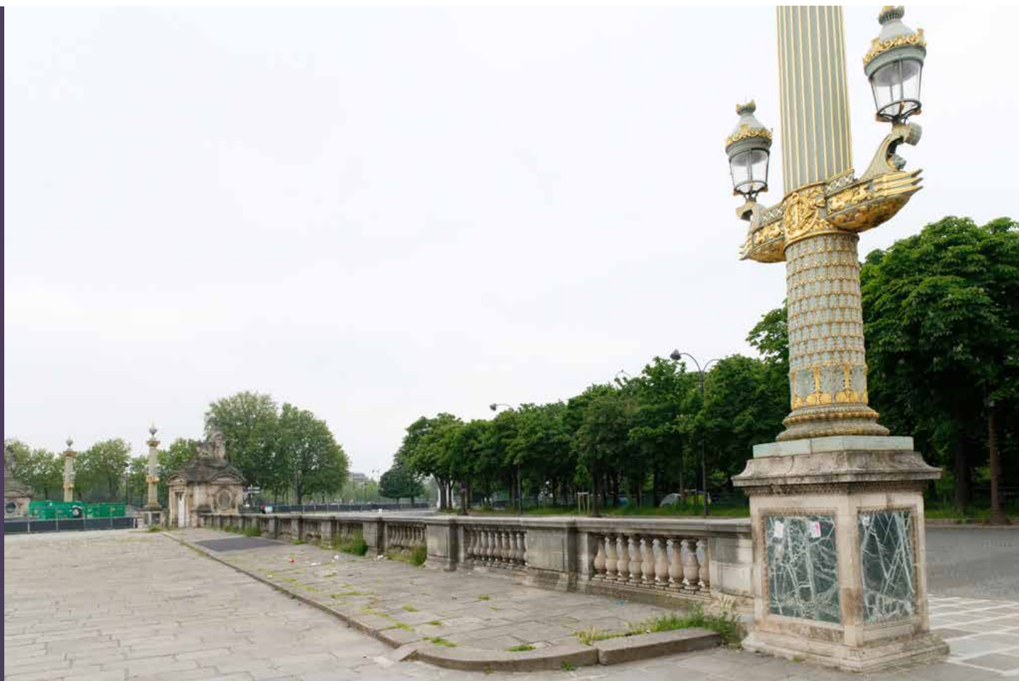
30c. : Balustrade à l'angle sud-ouest, février 2023
