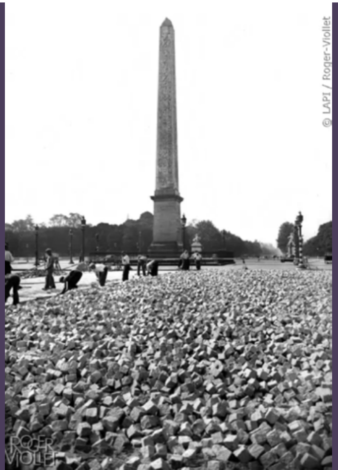
19c. Mise en place des petits pavés piqués sur la place de la Concorde, 1941 – Fonds Roger-Viollet
