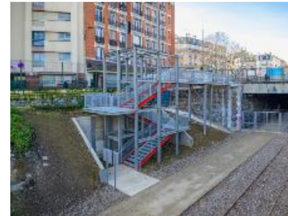
Escalier d'accès rue d'Ornano
