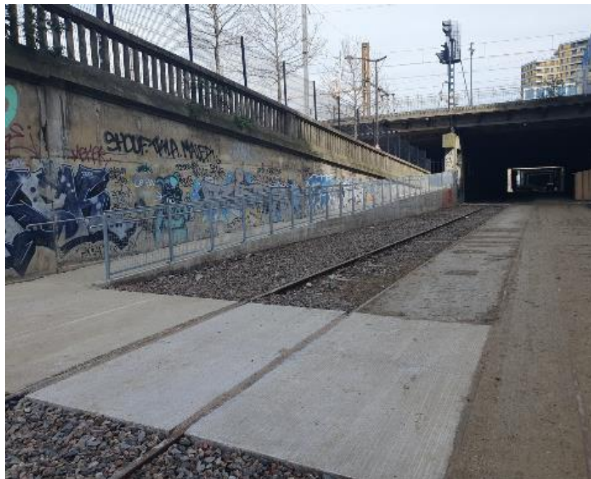
Rampe d'accès rue du Poissonniers
