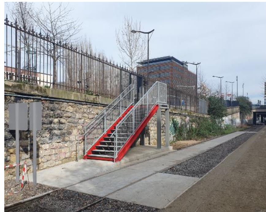
Escalier d'accès arrêt Tramway
