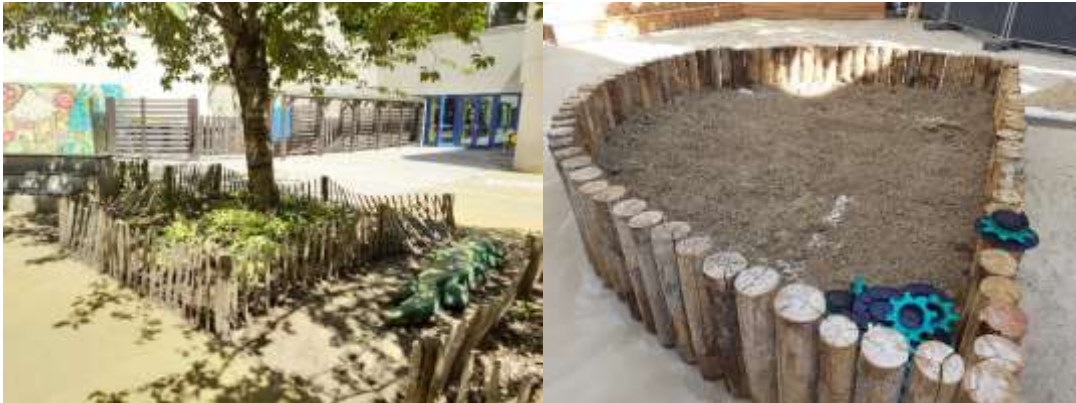
Photographie 9 : GS 132 Aubervilliers (19 e ) et EM rue des Tapisseries (17 e ) ganivelles provisoires endommagées et délimitation pérenne en rondins
