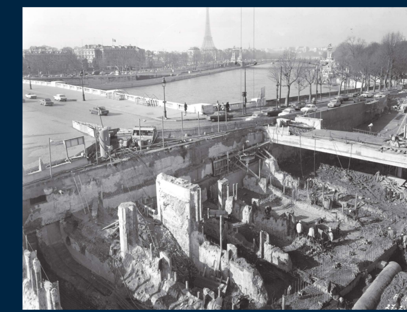
Vue en hauteur de la construction du tunnel
