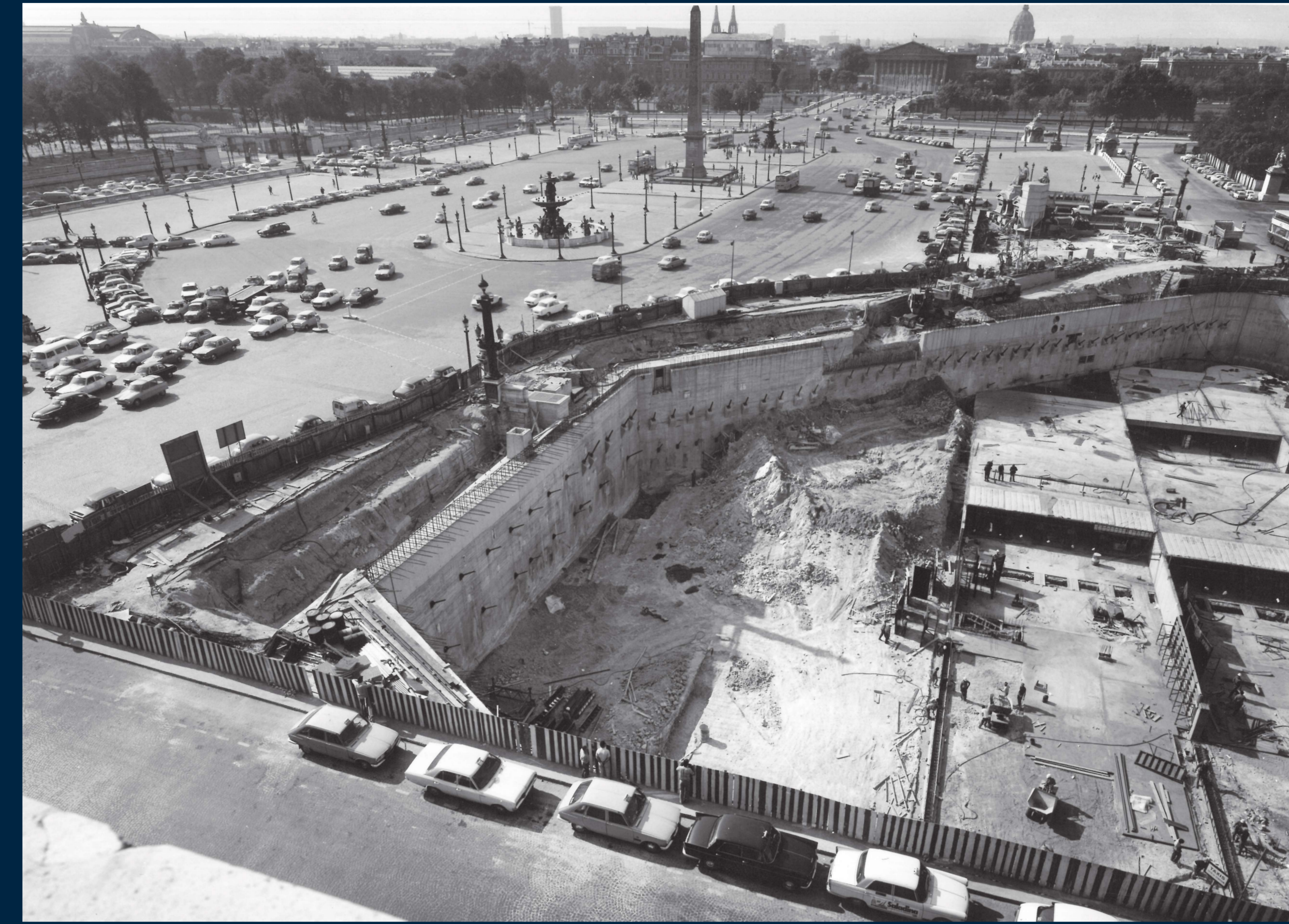
Vue en hauteur de la construction du parking souterrain
