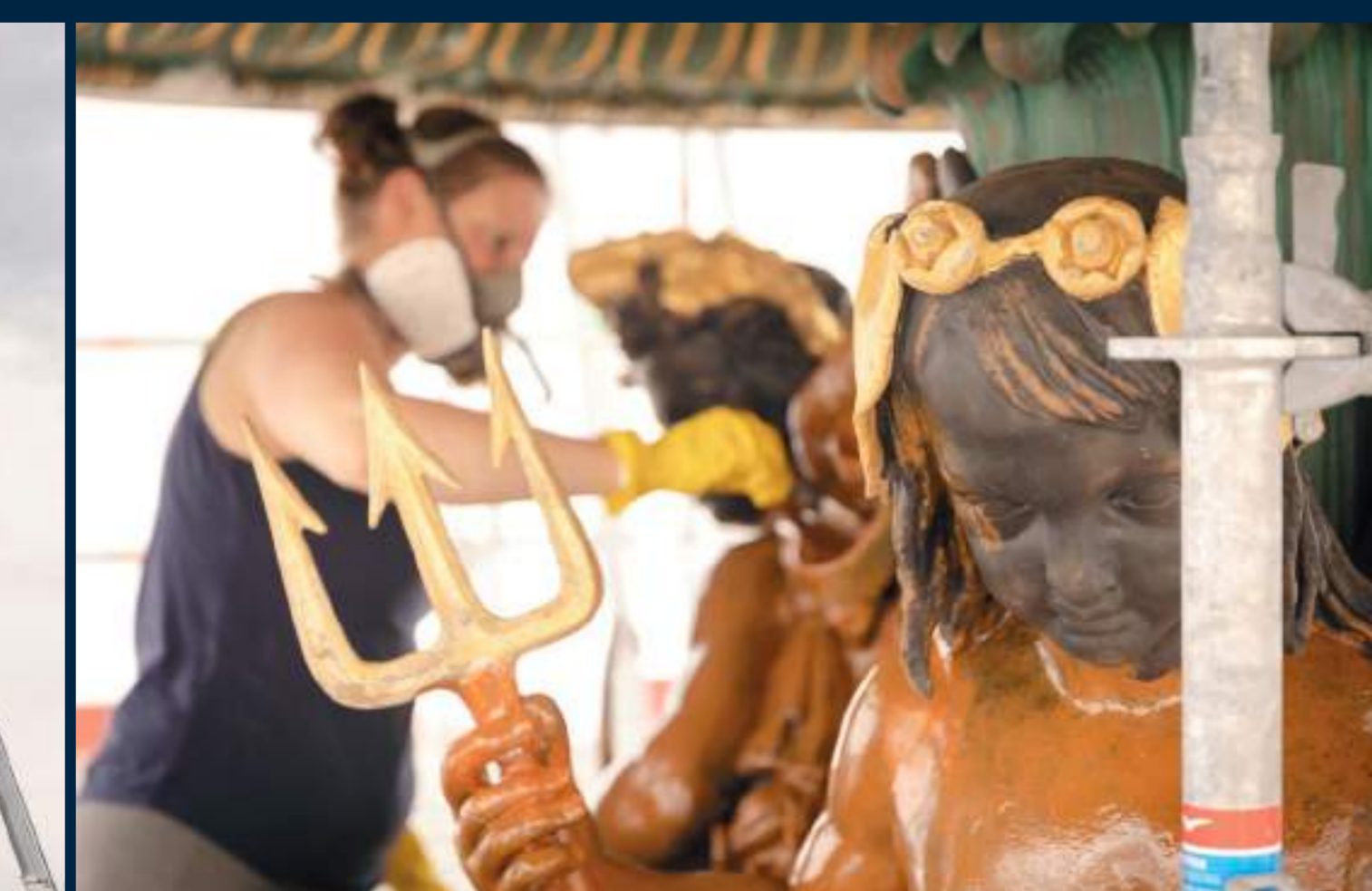
Rénovation des fontaines et des basses-reliefs de la Concorde
