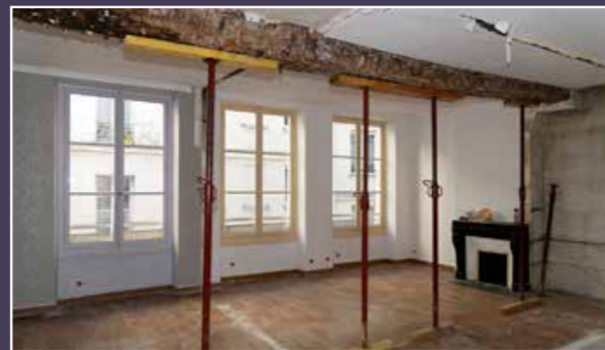
Étaïement dans le corps de logis sur rue, 2023.
