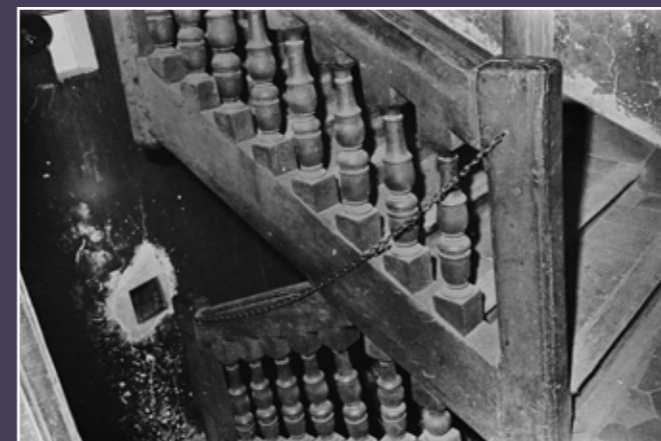
Vue de l'escalier du n° 11, 1967 (Archives de la CVP).
