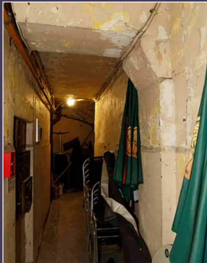
Vue de l'« allée » du n° 11, 2023.
