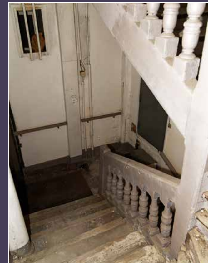
Vue de l'escalier du n° 11, 2023.
