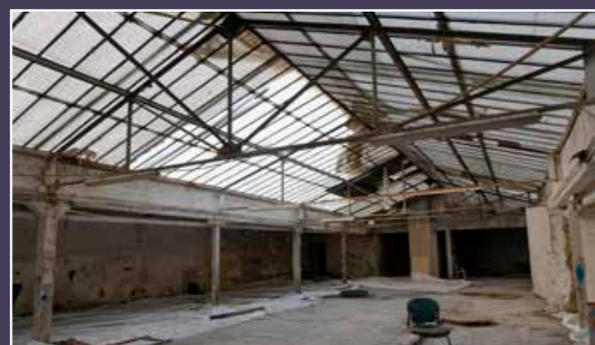
Vue de la charpente métallique du garage, 2023.
