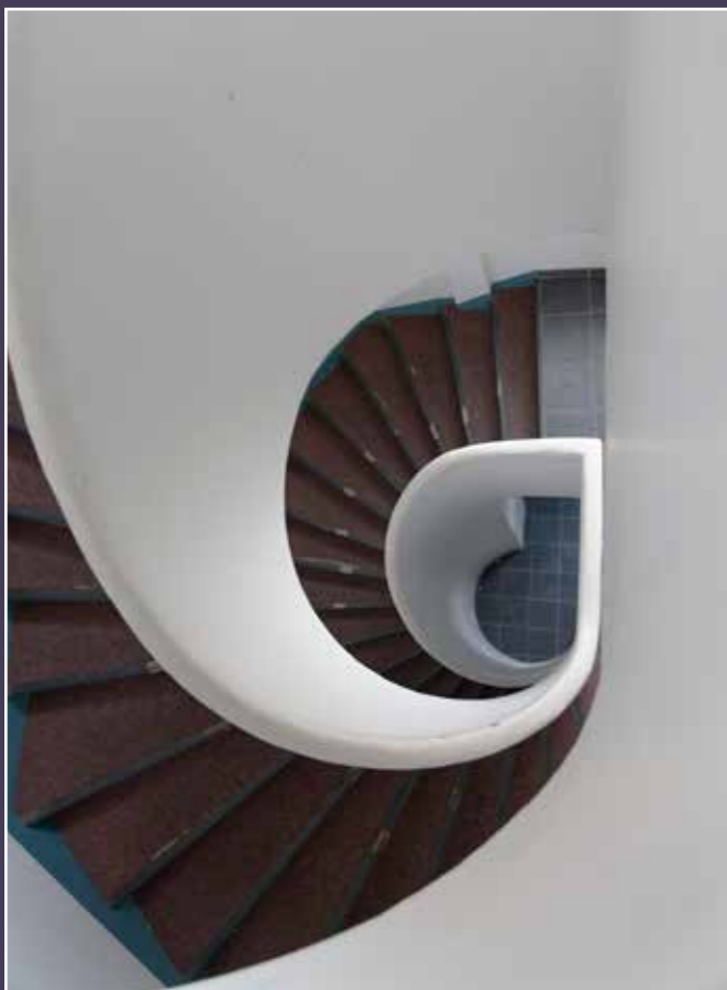
Vue de l'escalier en béton du garage, 2023.
