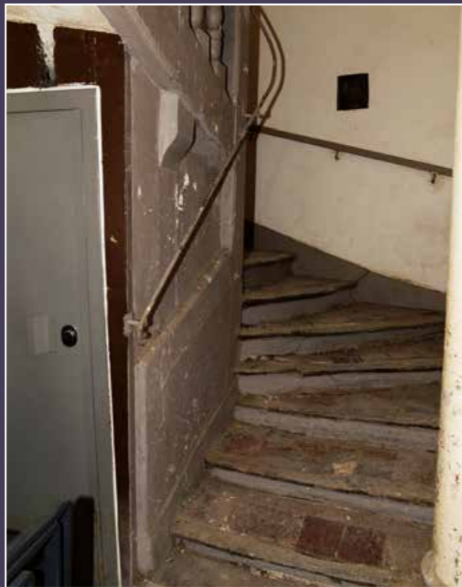
Vue de l'escalier du n° 11, 2023.
