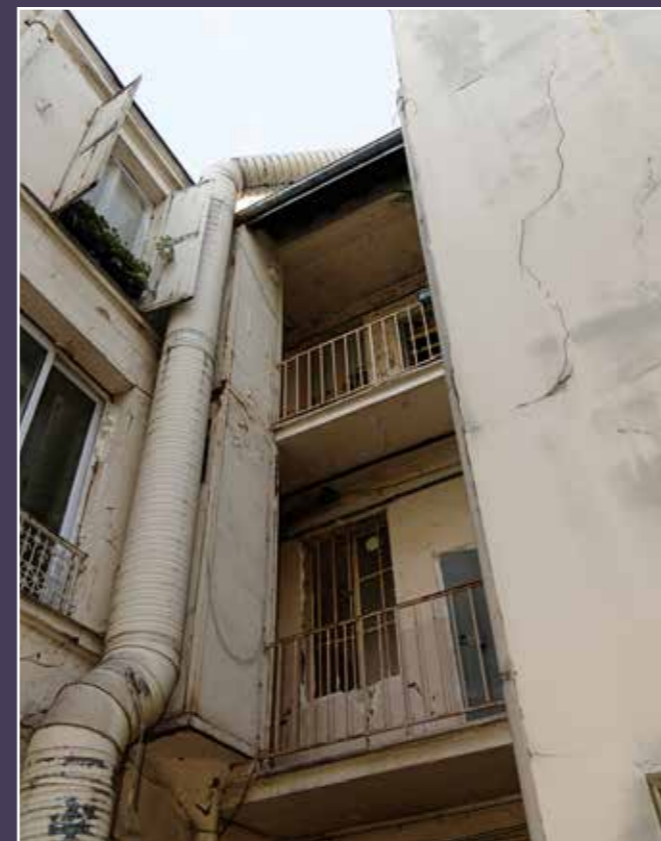
Cour du n° 9, vue des coursives, 2023.
