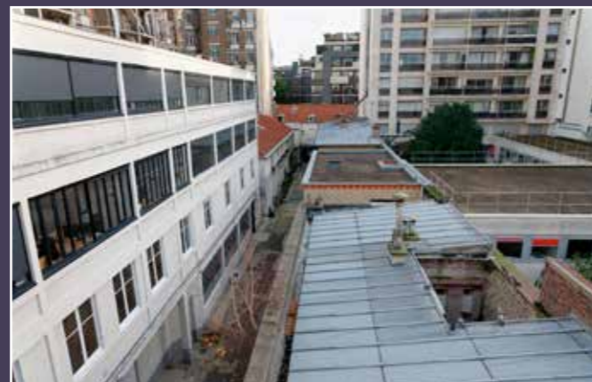
Vue depuis le garage des ateliers et pavillons, 2023.
