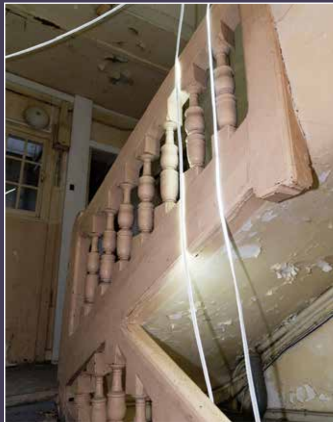
Vue de l'escalier du XVII e siècle au n° 9, 2023.
