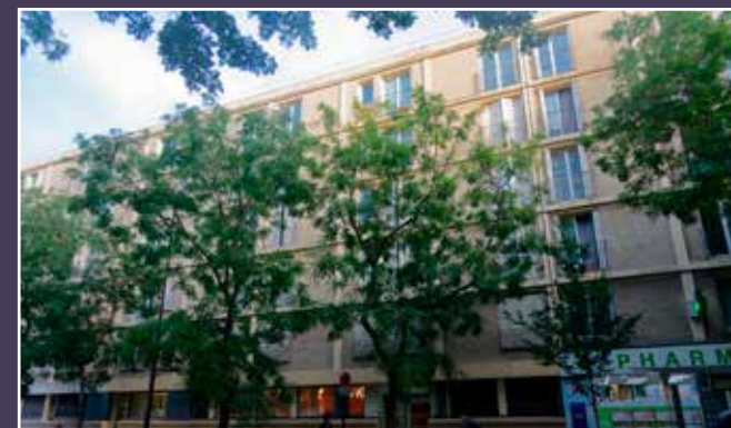
Vue des bâtiments A-A' promis à la démolition, depuis la rue Tolbiac, 2023 (© DHAAP / PS).
