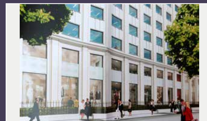
J.-J. Ory, réhabilitation d'un immeuble à usage de bureaux, activités et parking, insertion paysagère, 1999 (AD75).
