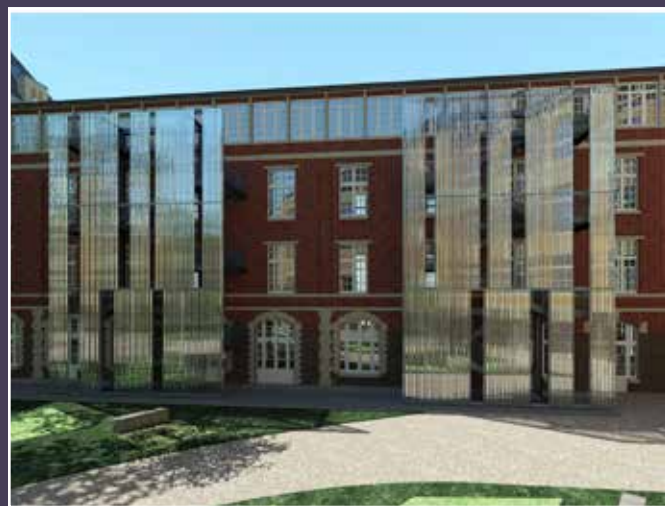
Vue d'insertion sur l'aile Hardy avec les escaliers extérieurs (© CALQ).
