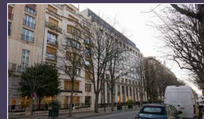
Vue de la façade au 22-24 avenue Montaigne, 2024 (© DHAAP / PS).
