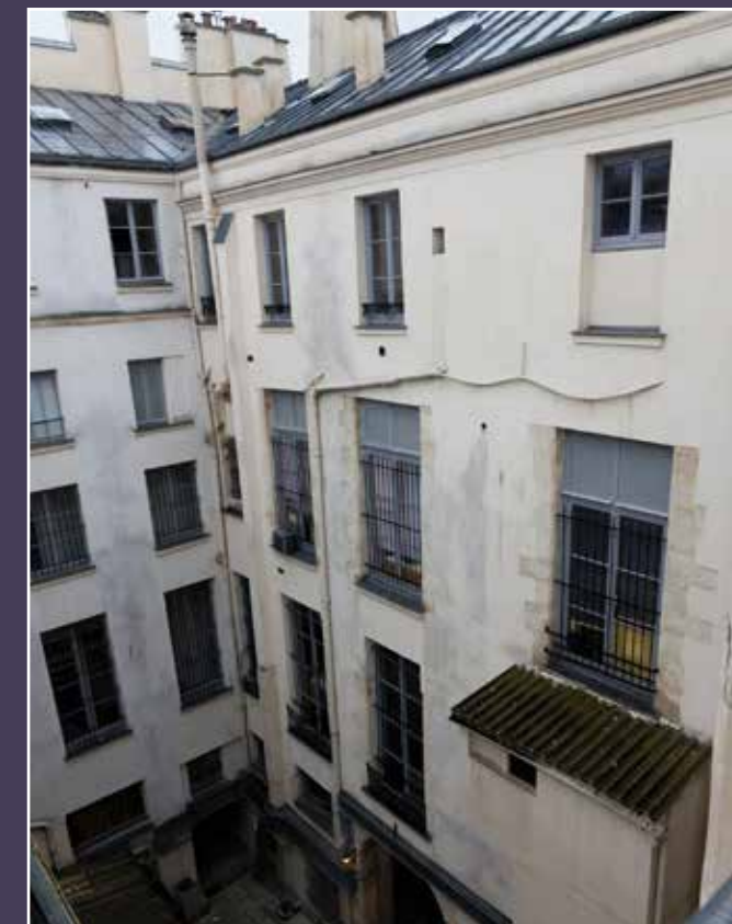
Vue de la façade sur cour du corps de logis principal, 2022 (© DHAAP / PS).
