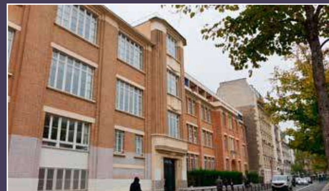
Vue de la façade sur le boulevard, 2019 (© DHAAP / PS).
