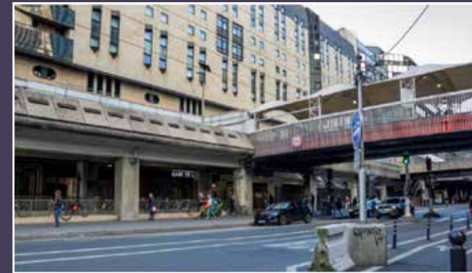
Vue actuelle de la dalle et de sa liaison avec l'opération, côté Seine (© AREP).
