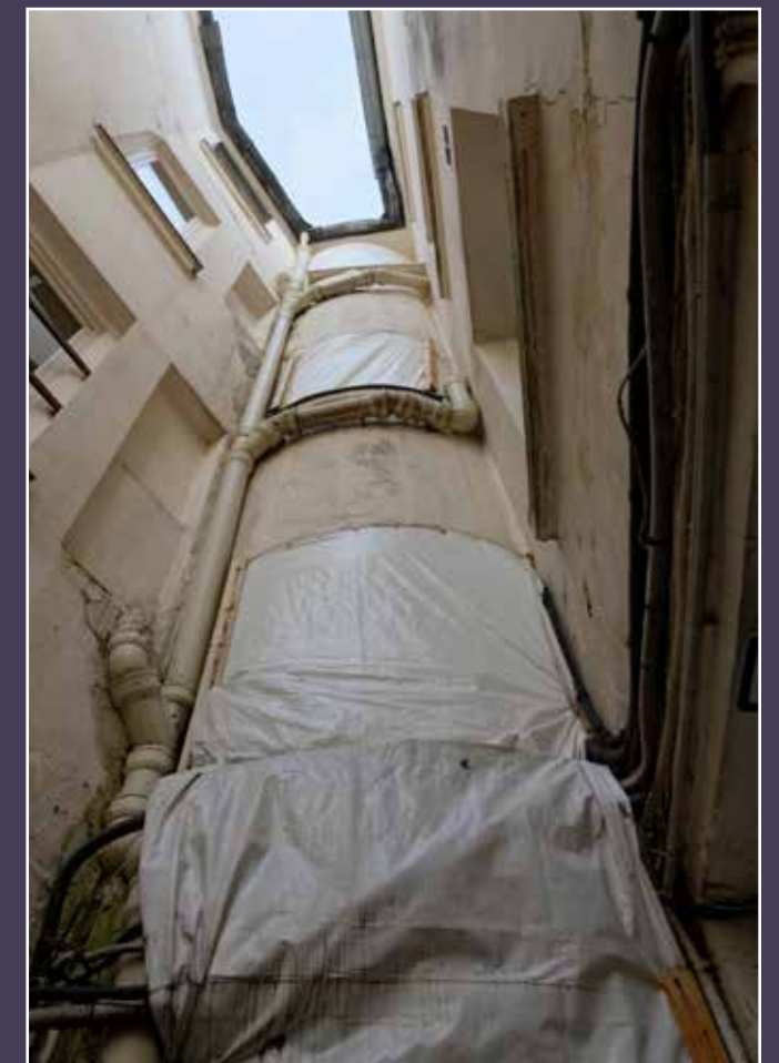
Cage d'escalier, extérieur, 2024 (© DHAAP / PS).
