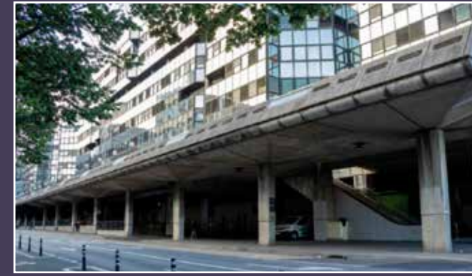
Vue des poteaux en béton et de la dalle, rue de Bercy (© AREP).
