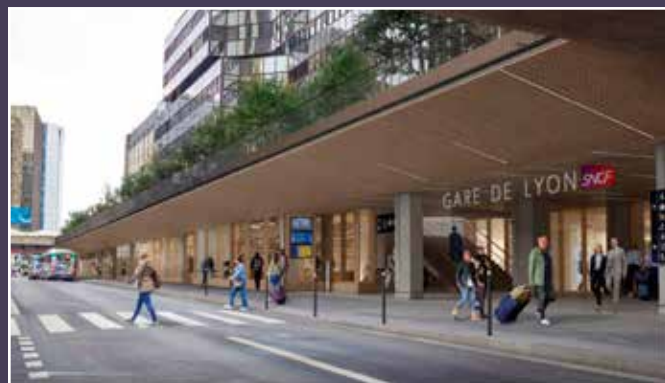
Vue projetée sur la rue de Bercy, avec le bardage bois de la sous-face de la dalle et les vitrines (© AREP).
