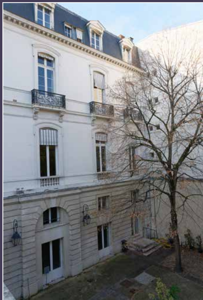
Façade sur jardin de l'hôtel de Luppé, 2024 (© DHAAP / PS).
