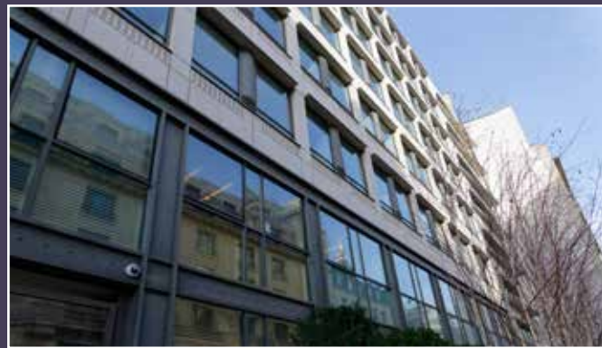
Vue de la façade au 24-32 rue Jean Goujon, 2024 (© DHAAP / PS).
