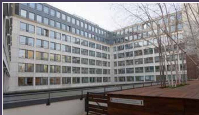
Vue des façades sur cour depuis la terrasse au-dessus de l'auditorium, 2024 (© DHAAP / PS).
