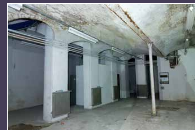
Vue des caves situées sous la cour, 2022 (© DHAAP / PS).
