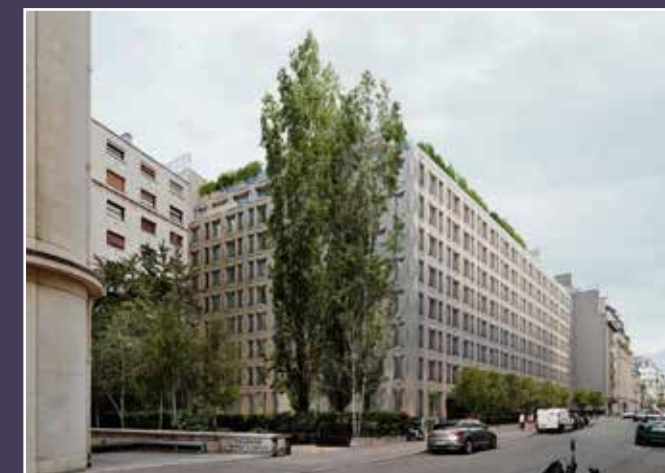
Insertion de la nouvelle façade sur la rue Jean Goujon (© Sanaa + Dubuisson Architecture).
