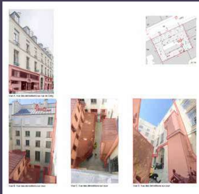
Photographies des démolitions (© Moatti-Rivière).
