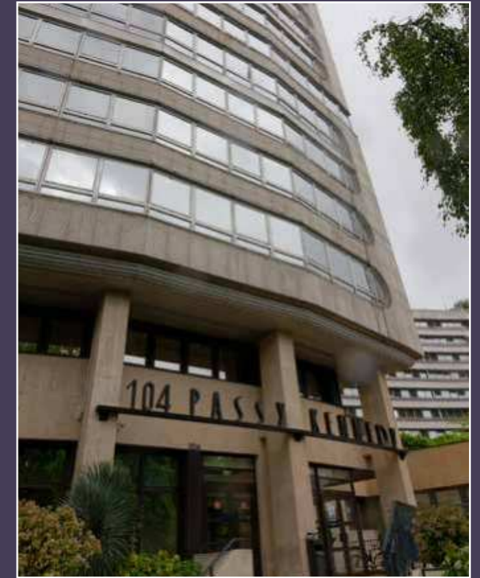
Vue de l'entrée principale côté Seine.
