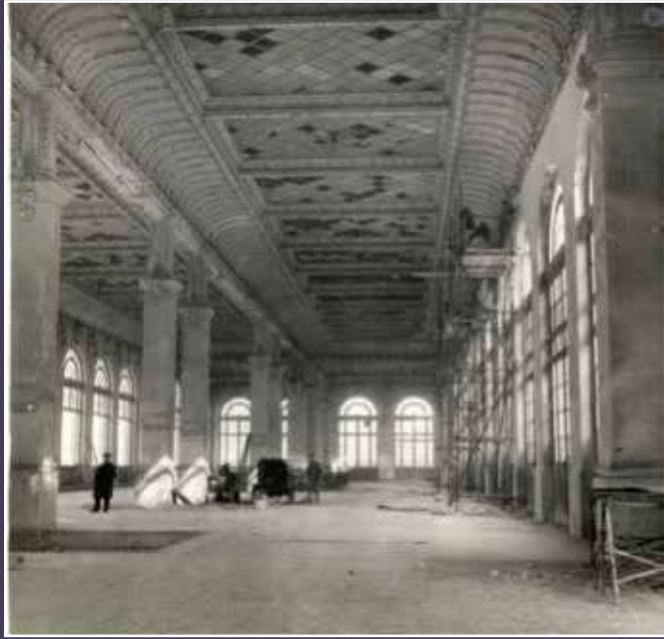
Paris - Aérogare des Invalides - Intérieur de la gare des Invalides avant les travaux d'Air France, 1946 (Musée Air France).
