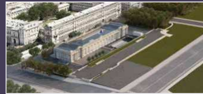
Vue aérienne, état existant (© Perrault / Gatier / Benech).
