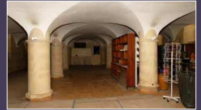
Vue actuelle du sous-sol de la chapelle.
