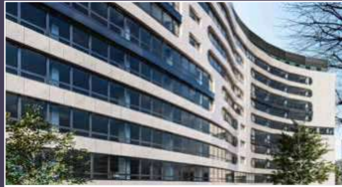
Détail après mise en oeuvre de l'ITE (© Naco & Praxis Architecture).
