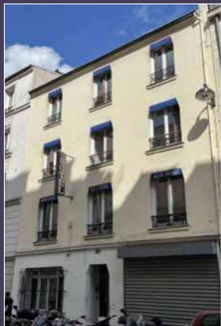
Vue actuelle de la façade sur rue (© B. architecture).
