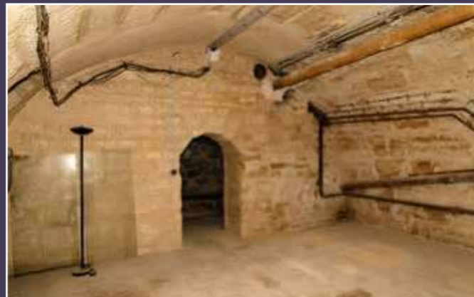
Vue actuelle d'un des deux berceaux de la cave.
