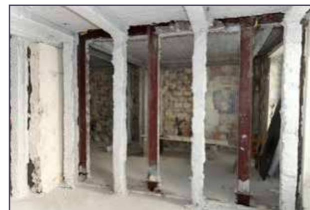
Vue actuelle des intérieurs du bâtiment.
