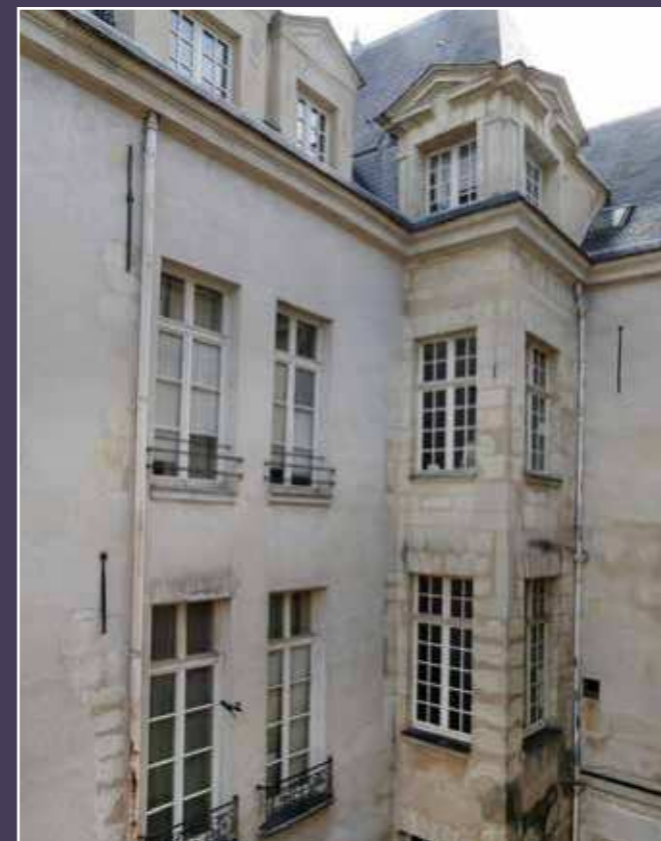
Vue de la tourelle abritant l'escalier principal.
