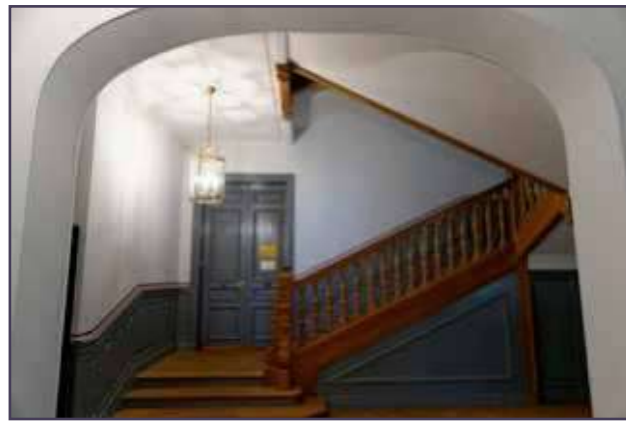
Vue actuelle de l'escalier principal depuis le hall d'entrée.
