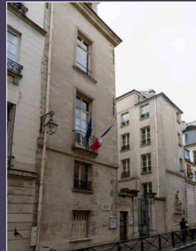
Vue de l'hôtel depuis la rue de Sévigné en 2018.
