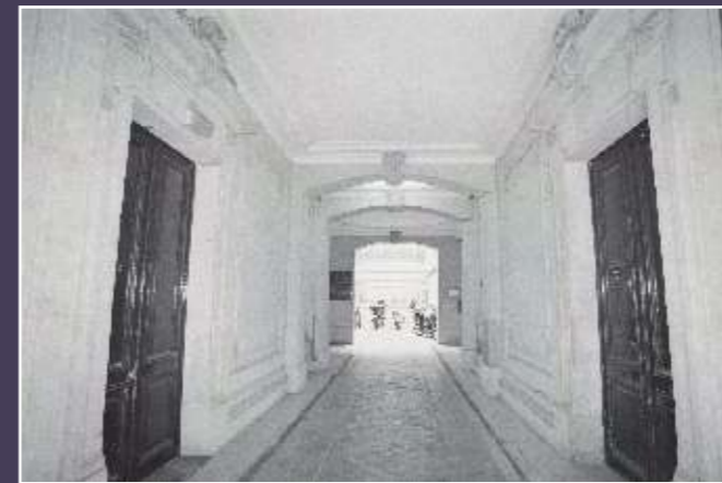
Vue du porche d'entrée du bâtiment au numéro 8 en 1999 (archives CVP).
