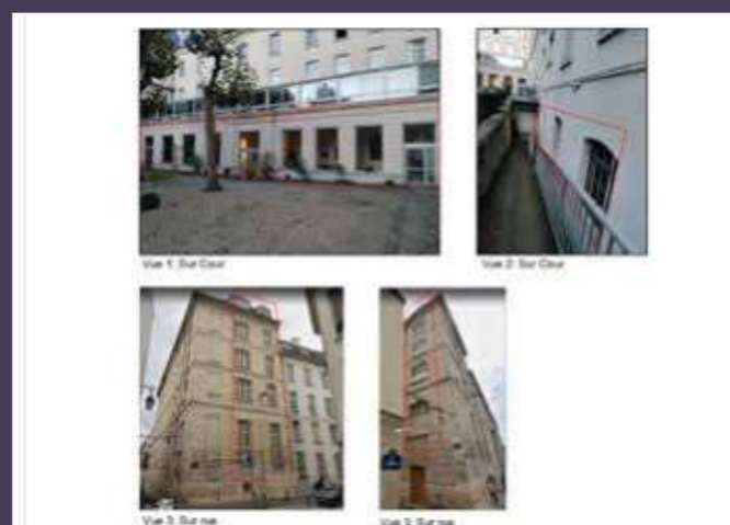
Vues actuelles présentant les menuiseries dont le remplacement est demandé (© P-Tiessé architecte).
