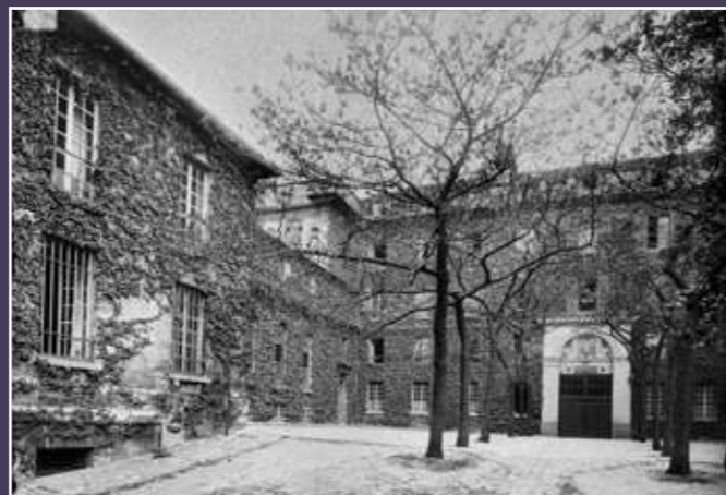
Charles Lansiaux, photographe, Vue de la cour, angle nord-est , 1917 (Casier archéologique).
