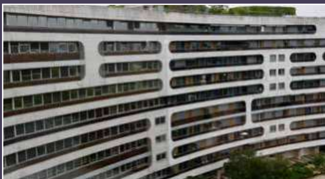
Vue de la jonction entre le premier immeuble de bureaux et le groupe de logements où se situera la rupture de la rénovation.
