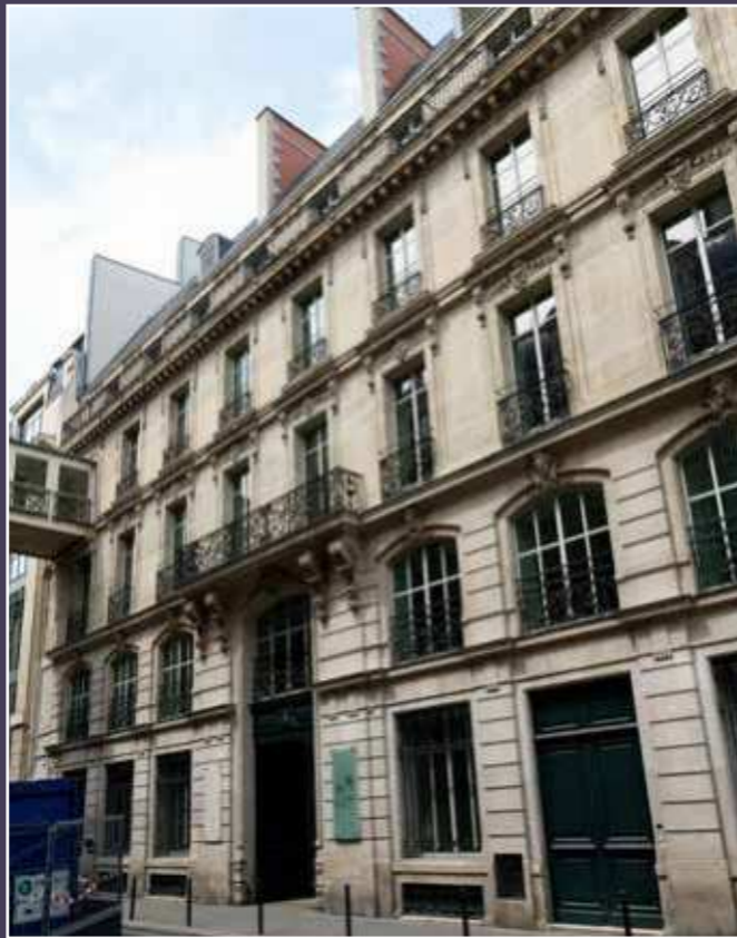
Vue actuelle de la façade sur rue du numéro 8.
