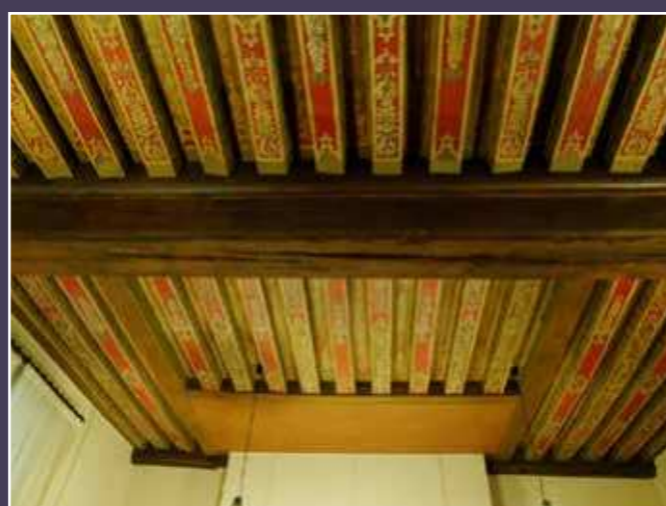
Vue d'un plafond à poutres peintes.
