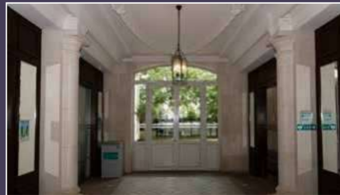
Vue actuelle du prolongement du porche réalisé en 2002.
