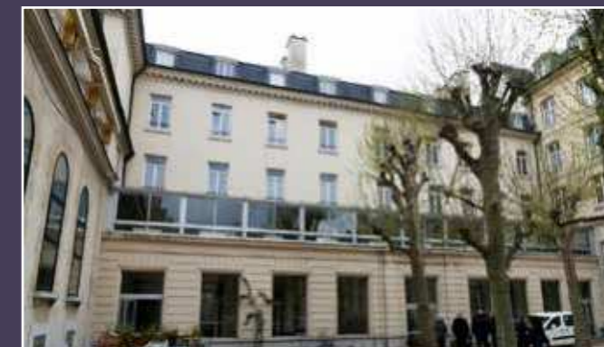
Vue de la galerie et du couloir vitré, état actuel.
