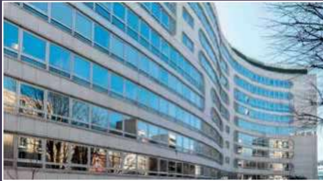
Détail de la façade existante côté bureaux.
