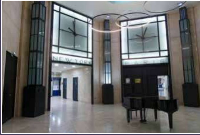
Vue du hall de desserte qui apparaît sur les plans de 1985 et sera démolé.
