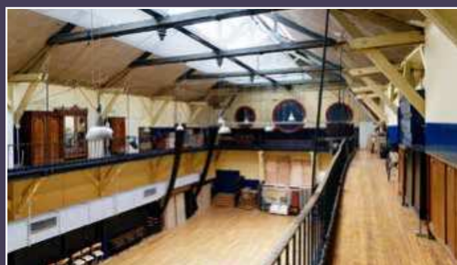
Vue actuelle de la halle depuis la coursive.
