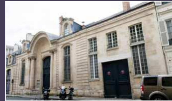
Vue actuelle de la façade sur rue.
