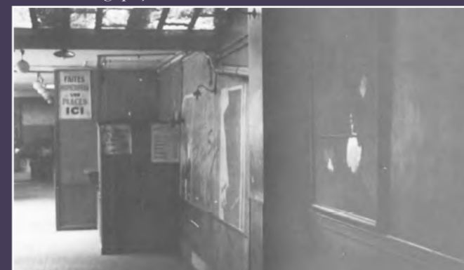
Vue de la billetterie dans le bâtiment A, entre-deux-guerres (Casier archéologique).
