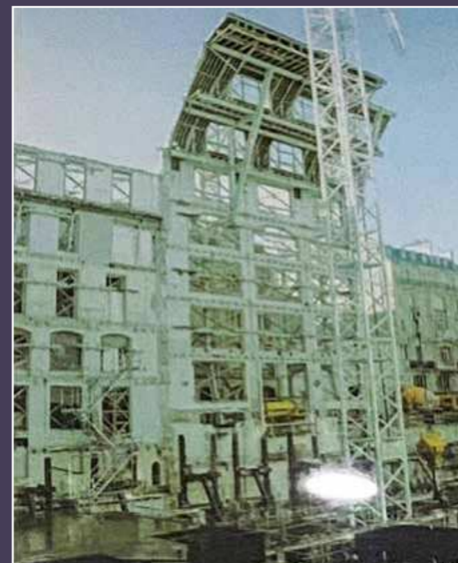
Cliché du chantier mené en 2002 : seules les façades aux numéros 8 et 10 et la toiture du numéro 10 sont maintenues (Arte Charpentier, cliché transmis par la maîtrise d'œuvre).
