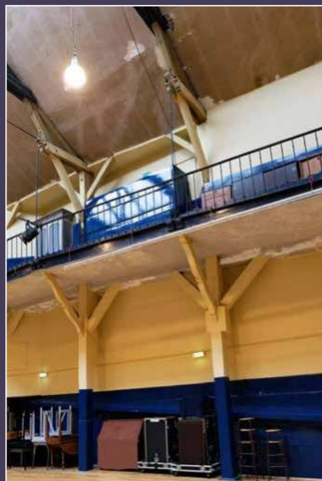
Vue actuelle de la structure en bois qui soutient la coursive.
