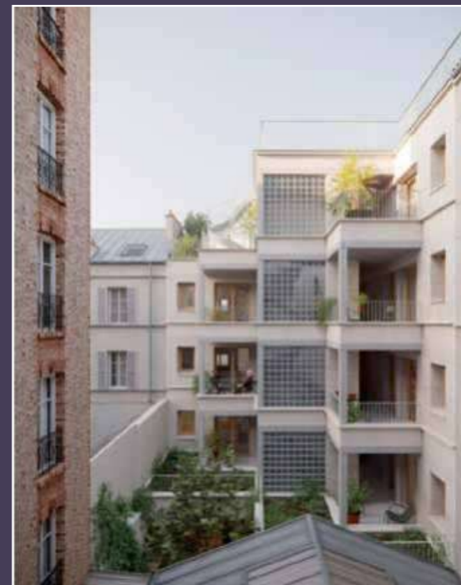
Vue d'insertion en coeur de parcelle (© Pascaline Gasc architecte).
