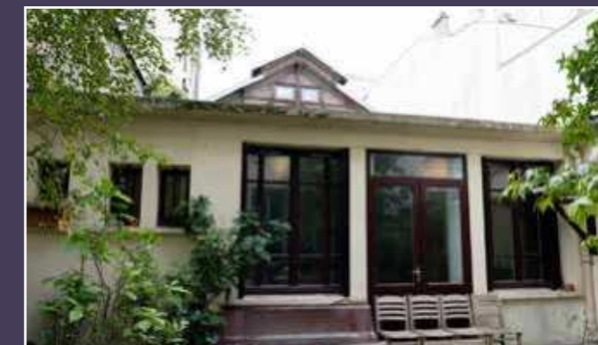
Vue actuelle de la façade sur cour du bâtiment B construit entre 1968 et 1976.
