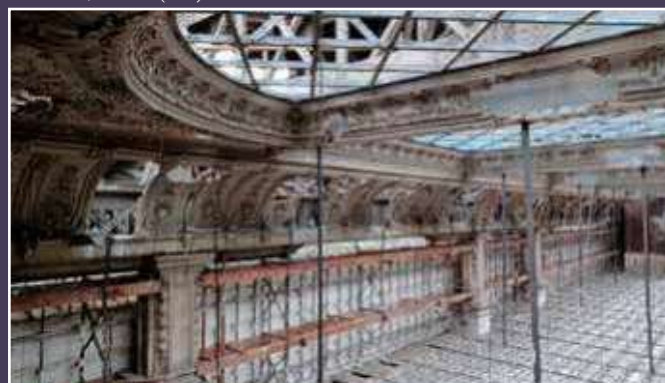
Gare des Invalides, vue sur le plafond en verre, fer et stuc d'origine de la gare, 2022 (S. Texier).
