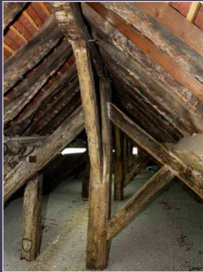
Vue actuelle de la charpente de l'aile historique.
