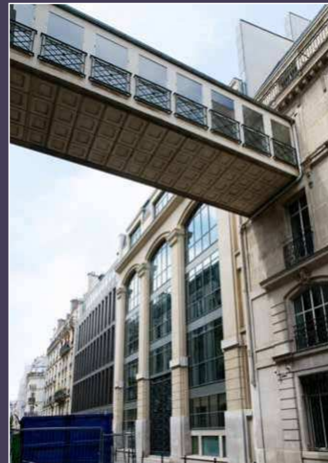
Vue actuelle des façades du 10 et 12, rue Sainte-Cécile, ainsi que de la passerelle reliant le numéro 8 avec le siège social.
