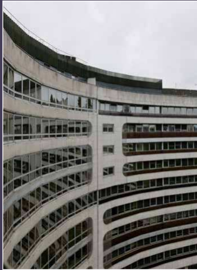
Vue de la jonction entre les deux immeubles de bureaux qui seront rénovés.
