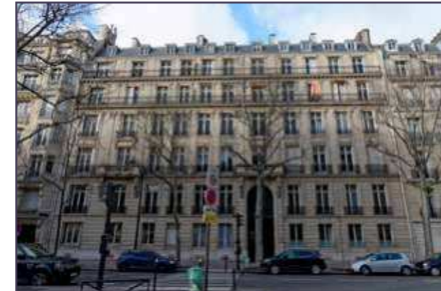
Vue actuelle de la façade sur l'avenue.
