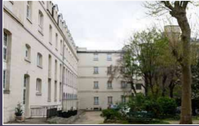
Vue de l'angle sud-ouest, état actuel.
