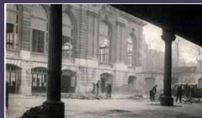
Paris - Aérogare des Invalides - Travaux d'aménagement de la rampe des bus sous la dalle , 1946 (Musée Air France).
