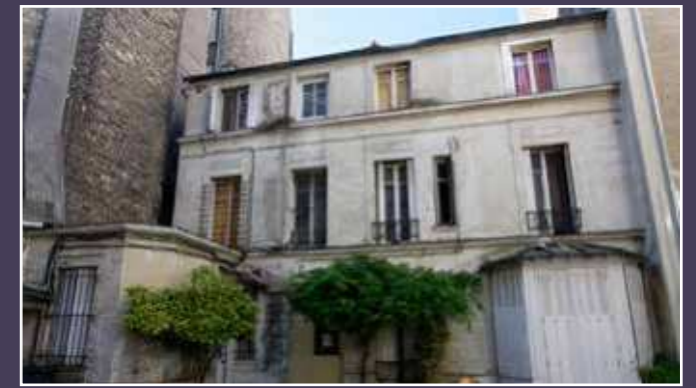
Vue actuelle de la façade sur cour.
