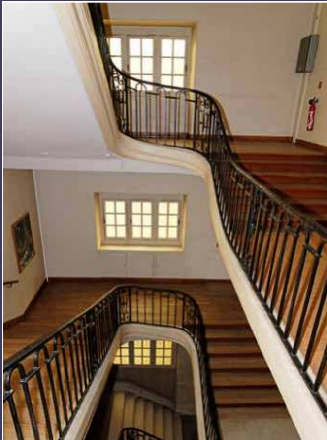
Vue actuelle du grand escalier.
