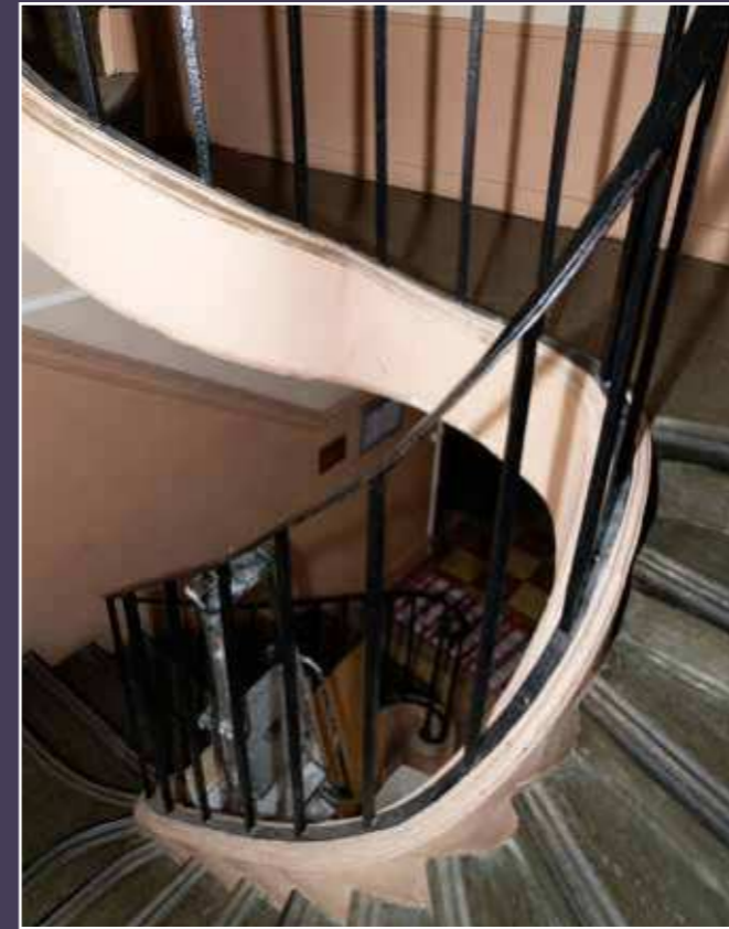
Vue actuelle de l'escalier du pavillon accolé à la chapelle.
