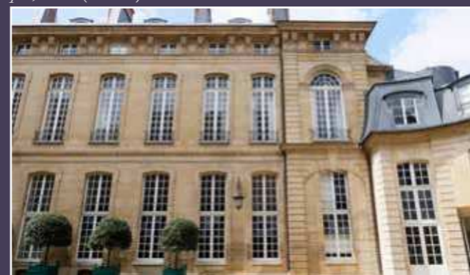
Vue actuelle de la façade sur cour de l'aile droite.
