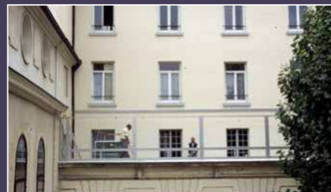
Mise en oeuvre du couloir vitré, 1998 (Archives spiritaines).
