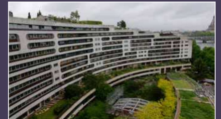
Vue générale des façades du côté de l'avenue du Président Kennedy.
