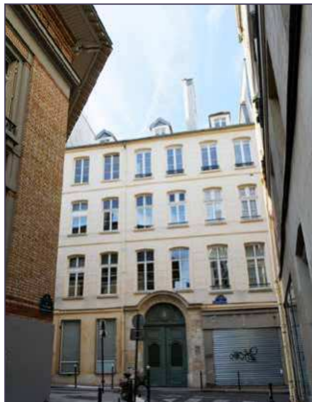
Vue actuelle du bâtiment sur rue.
