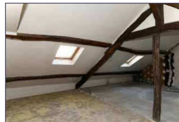
Vue actuelle de la charpente de la couverture.
