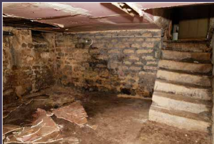
Vue actuelle des caves du bâtiment sur rue.
