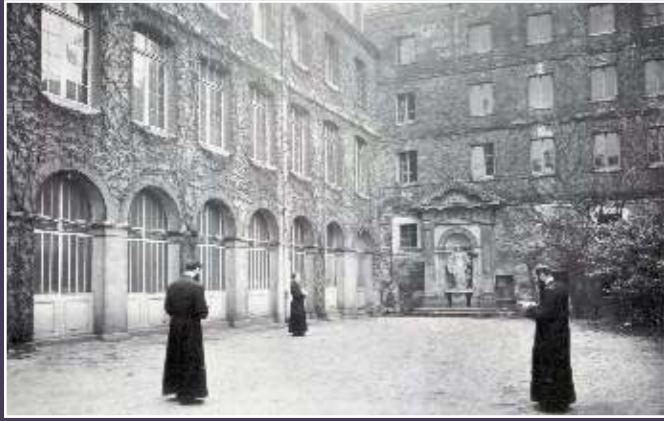
Vue de l'angle sud-ouest, 1935 (Archives spiritaines).
