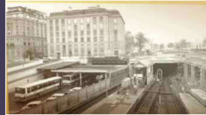
SNCF, Liaison ferroviaire Invalides-Orsay - Modification au niveau de l'esplanade des dalles de couverture des emprises de la SNCF - Voie sortant du côté de la rue Fabert, 1978 (AN).
