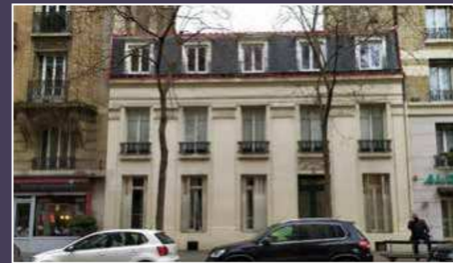
Vue actuelle de la façade sur l'avenue. En pointillés rouges, la démolition de la toiture envisagée (© Mootz / Pelé Architectes).
