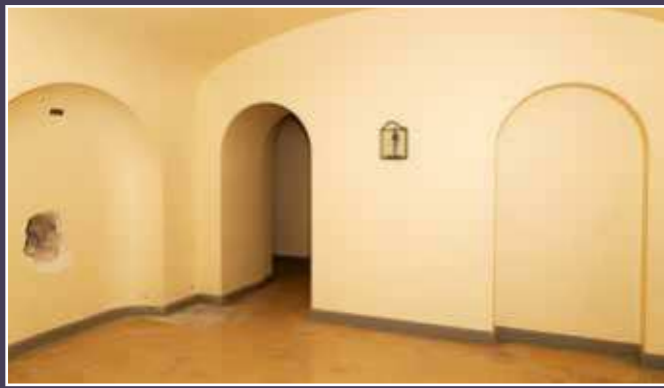
Vue des caves, état actuel.
