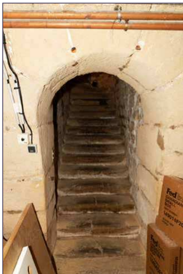
Vue actuelle de l'accès à la cave voûtée.
