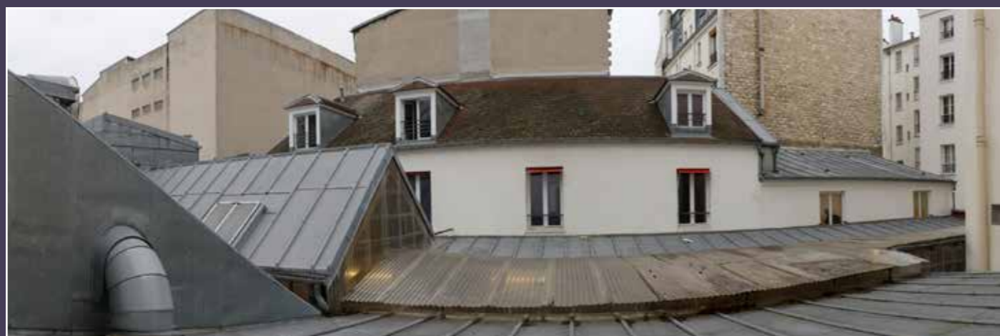
Vue de l'appentis est, 2023 (© DHAAP / PS).
