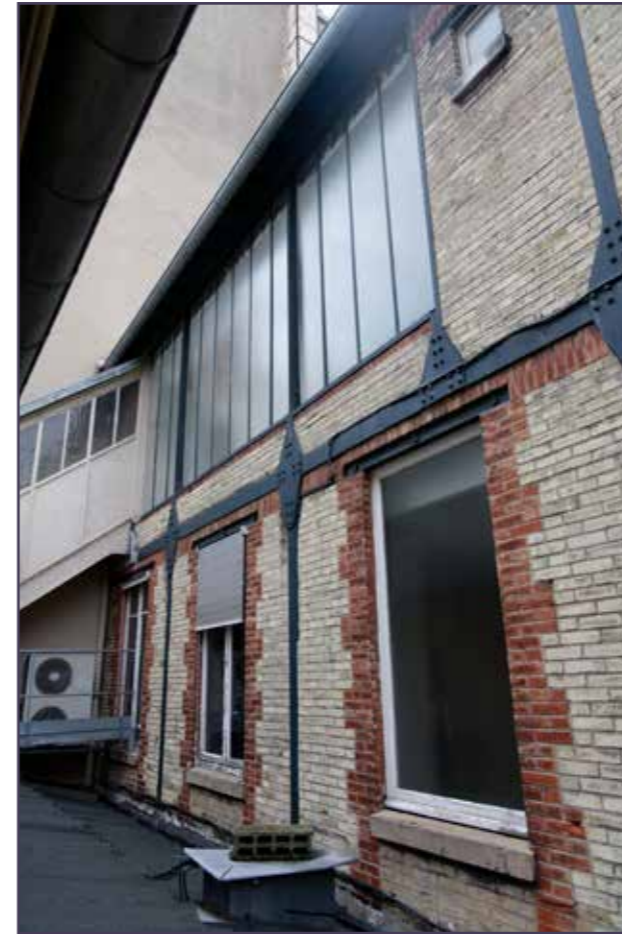
Élévation sur cour, 2024 (© DHAAP / PS).
