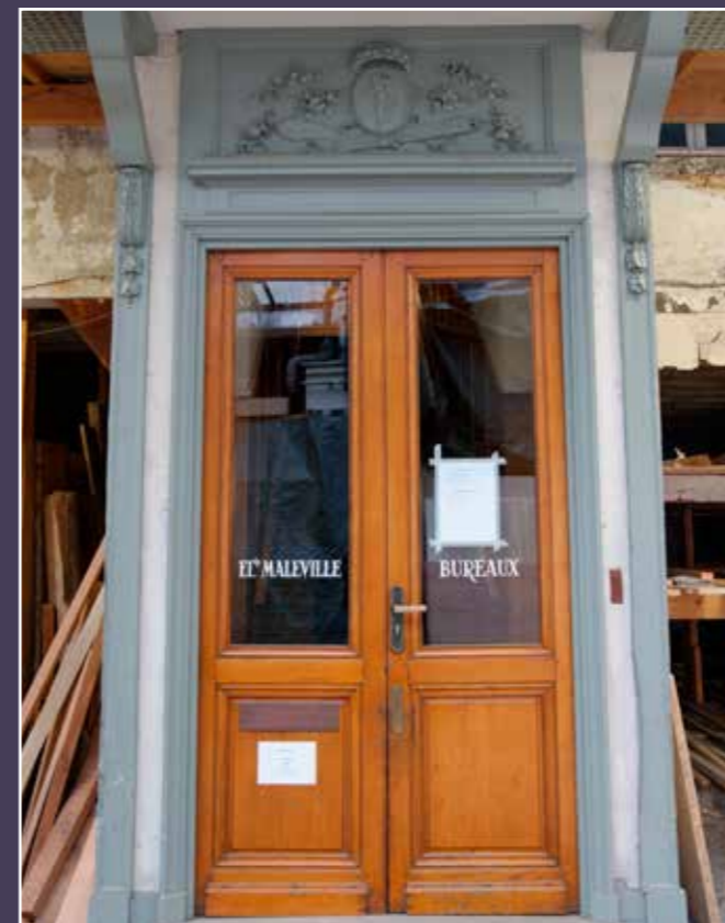
Vue de la porte d'entrée moulurée de l'appentis est, 2023 (© DHAAP / PS).
