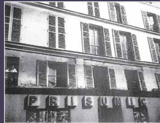
Élévation rue Lavoisier en 1973 (© RÉA).
