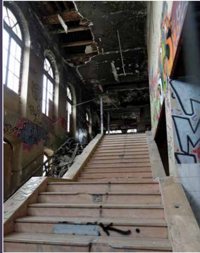
Vue intérieure de la gare en 2015, avec les vestiges de l'accès au RER (© DHAAP / PS).
