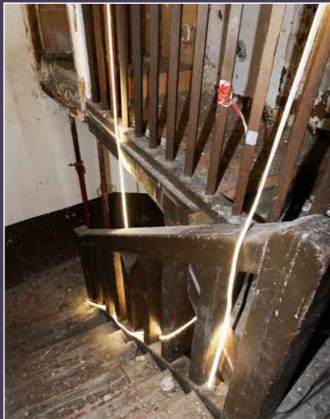
Vue de l'escalier rampe sur rampe, 2024 (© DHAAP / MI).
