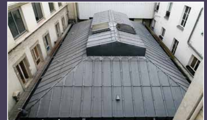
Vue de la verrière couverte en zinc (© Tolila + Gilliland Atelier d'architecture).
