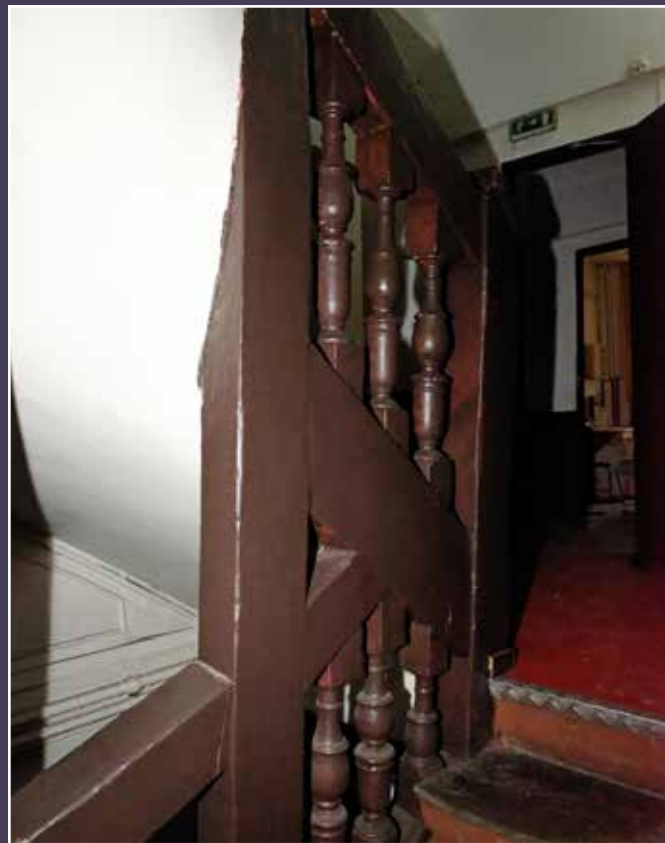
Vue d'une volée d'escalier, 2016 (© DHAAP / MI).
