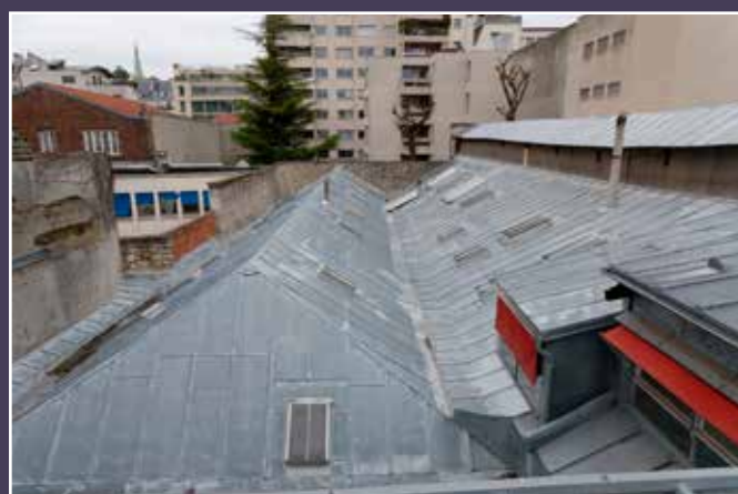
Vue des toitures de deux halles, 2023 (© DHAAP / PS).
