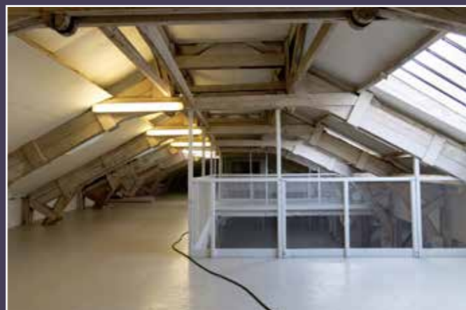
Vue de la mezzanine de la halle ouest, 2024 (© DHAAP / PS).
