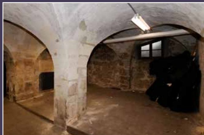
Vue des voûtes du 1 er sous-sol, 2013 (© DHAAP / ML).
