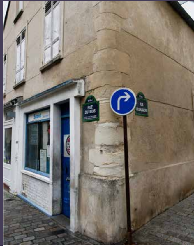
Détail de la chaîne d'angle en pierre de taille du bâtiment, 2023 (© DHAAP / ML).
