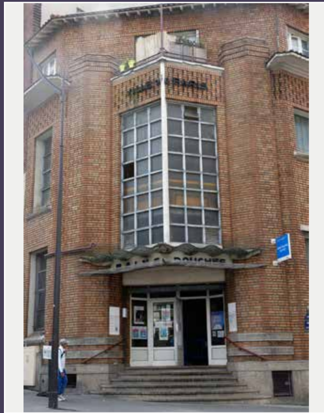
Vue de l'entrée principale, sa verrière, son mât et sa marquise, 2023 (© DHAAP / PS).
