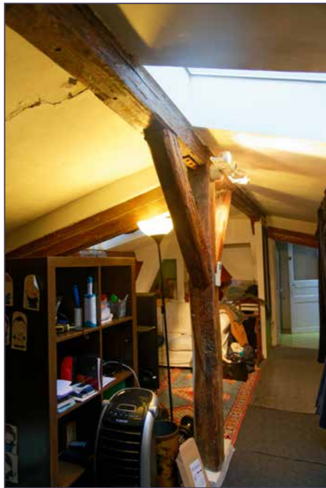
Vue de la charpente de l'appartement, 2024 (© DHAAP / PS).
