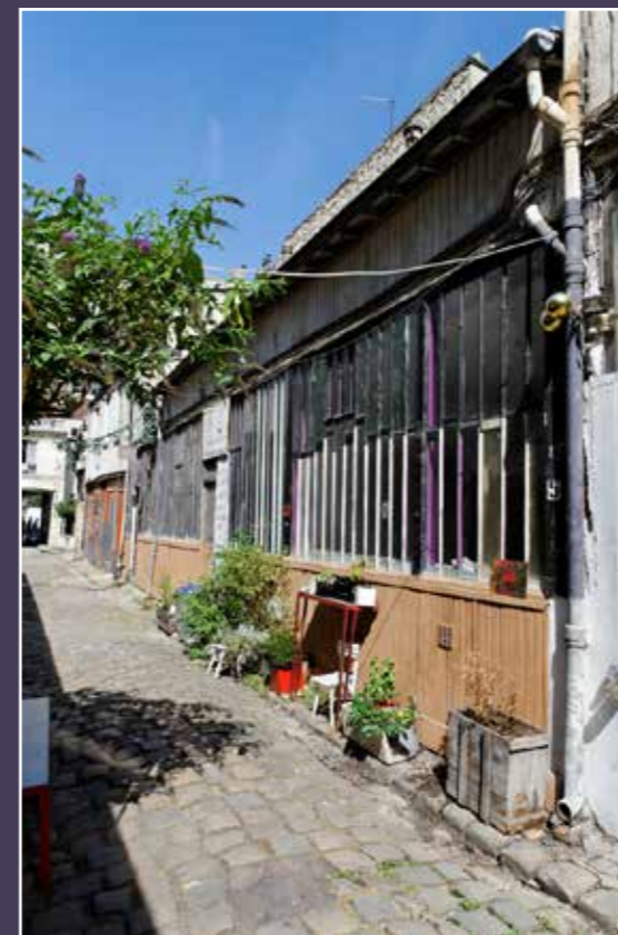
5 cité Durmar, vue avant démolition en 2012 (© DHAAP / Christian Rapa).
