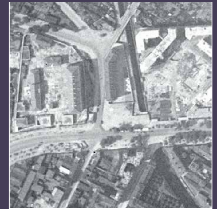
Vue aérienne, la caserne et la cité achevée, les HBM voisines en construction, 1931 (© IGN).
