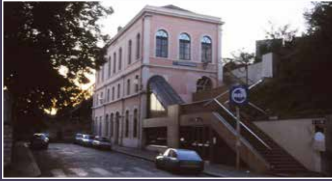
Vue de la gare encore en fonction depuis la rue Regnault avant les travaux d'aménagement urbain (Document Lina Ghotmeh – Architecture).
