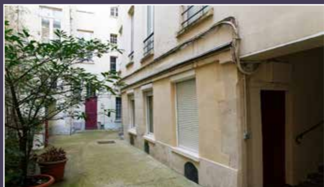
Vue du mur en pierre de taille de l'aile latérale, 2022 (© DHAAP / ML).
