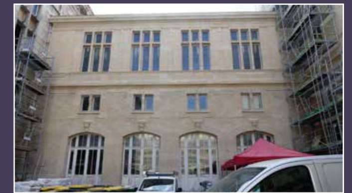
Vue de la façade arrière de l'aile qui longe le boulevard de l'Hôpital, 2023 (© DHAAP / PS).
