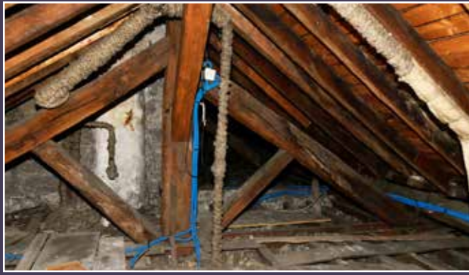
Vue de la charpente, 2023 (© DHAAP / ML).
