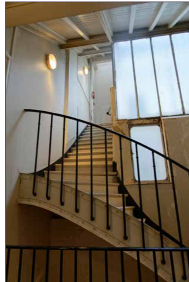
Vue de l'escalier métallique, 2024 (© DHAAP / PS).
