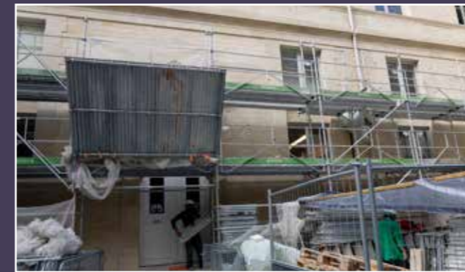
Vue de l'emmarchement situé dans la cour au revers du bâtiment principal, 2023 (© DHAAP / PS).
