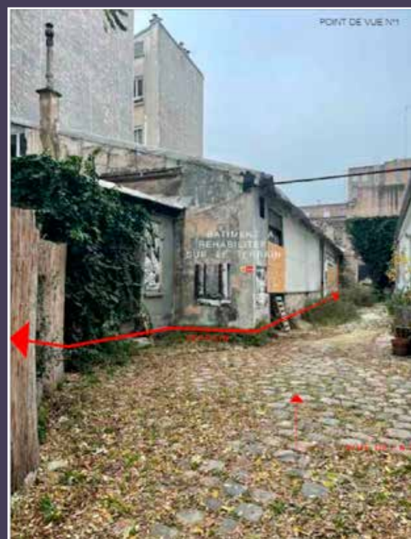
11 cité Durmar, état existant (© Ad Alterum architecte).
