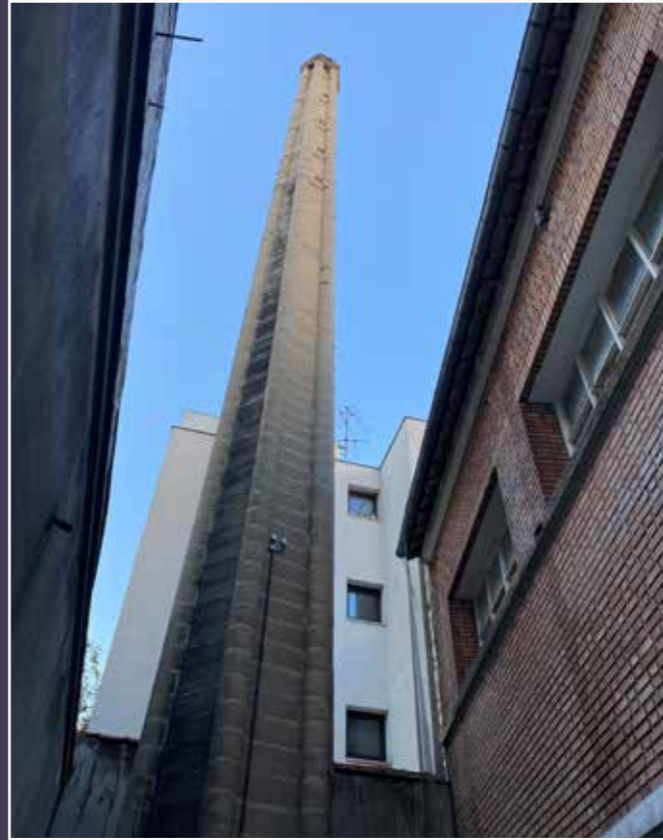
Vue de la cheminée, 2023 (© DHAAP / PS).
