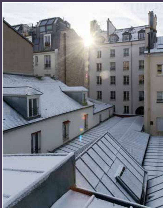
Vue sur l'appentis est et la cour couverte depuis le toit du bâtiment central, 2024 (© DHAAP / ST).
