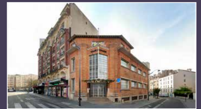
Vue d'insertion des bains-douches rénovés (© Architecte(s)).
