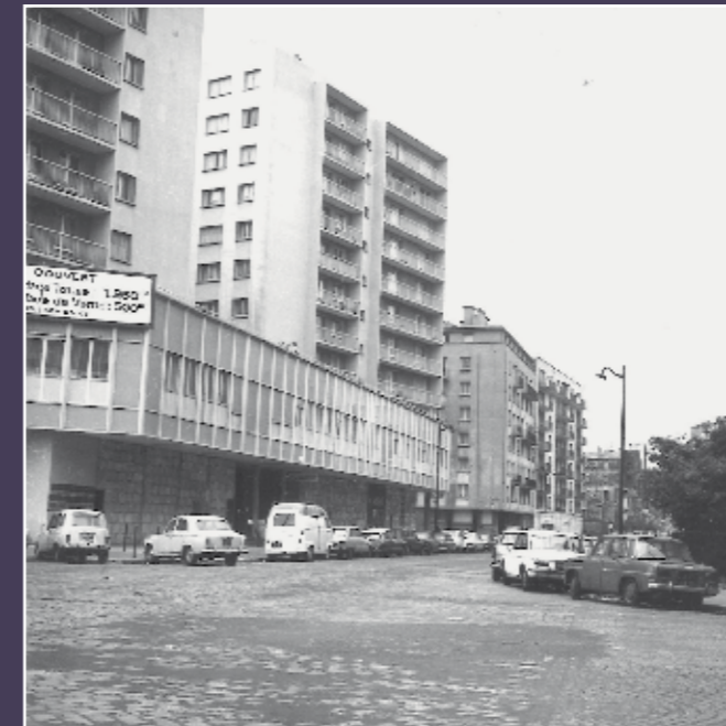
Vue depuis la rue Riquet, 1973 (© Pavillon de l'Arsenal / AP).
