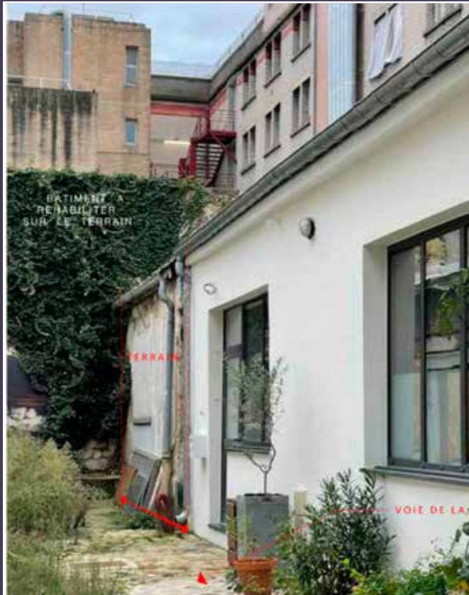
14 cité Durmar, état existant (© Ad Alterum architecte).
