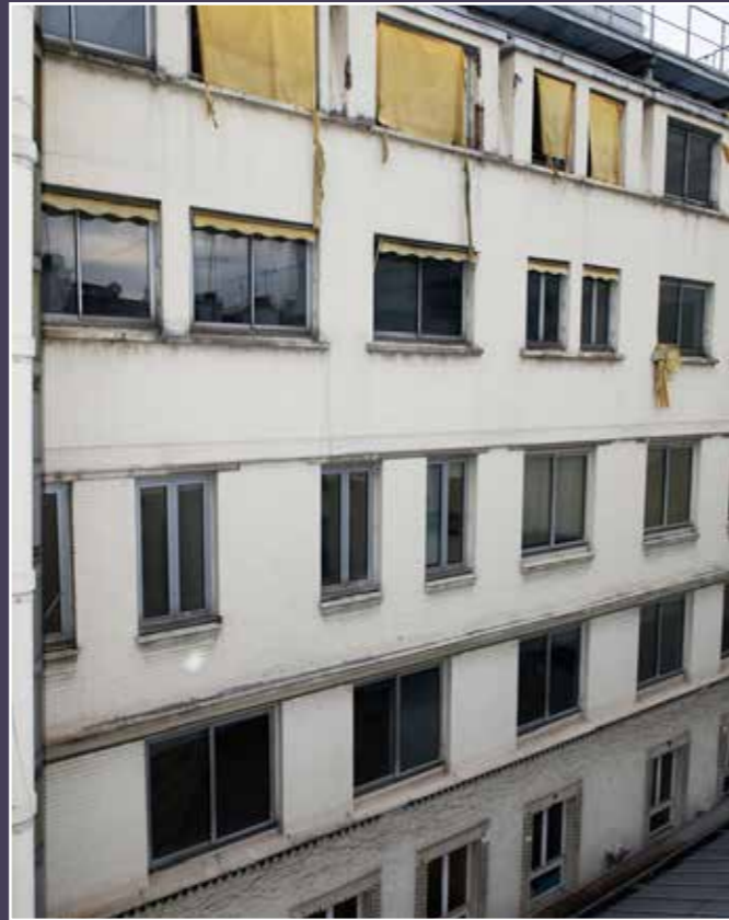
Vue de l'élévation du bâtiment de fond de cour du 22 rue Lavoisier, 2024 (© DHAAP / ML).
