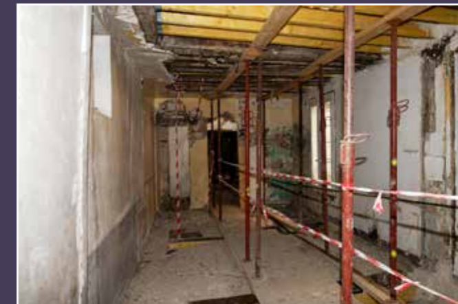
Vue des démolitions en cours dans l'aile arrière, 2024 (© DHAAP / MI).
