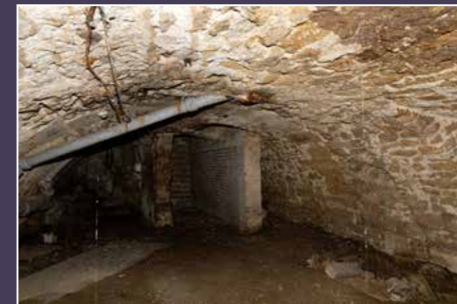
Vue d'un berceau de voûte dans la cave (© DHAAP / MI).
