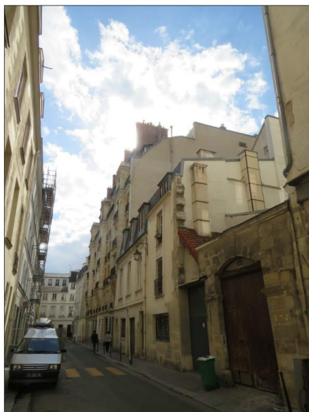
État de l'existant :
