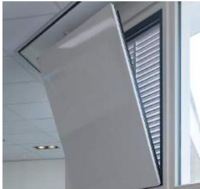
Dispositif de ventilation nocturne avec pare-pluie pour exemple, Duco
