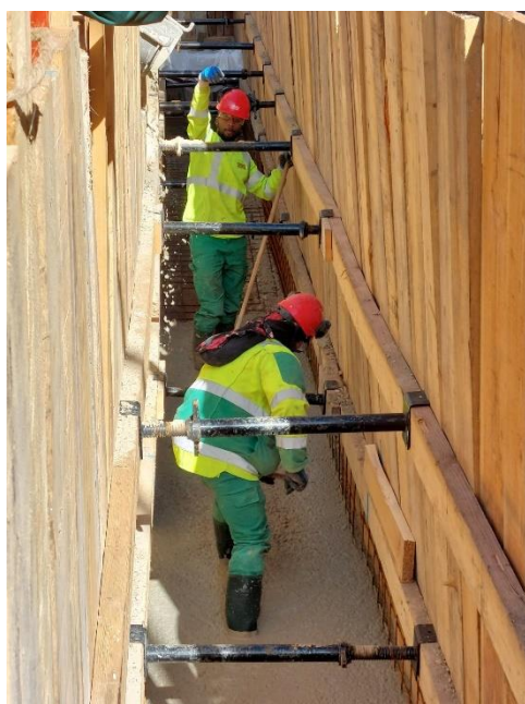
Coulage du béton très bas carbone, CPCU
