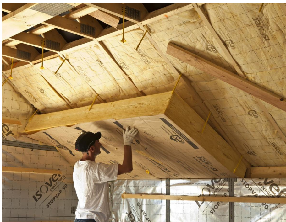
Pose d'un isolant en laine de verre 35 revêtue d'un kraft de 200 mm, Batirama
