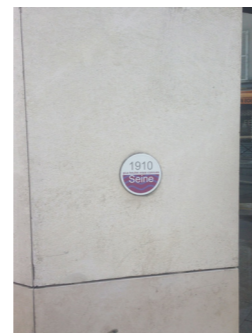
Muret du quai de Bercy Paris 12 e (Photo : Marc MULLER)
