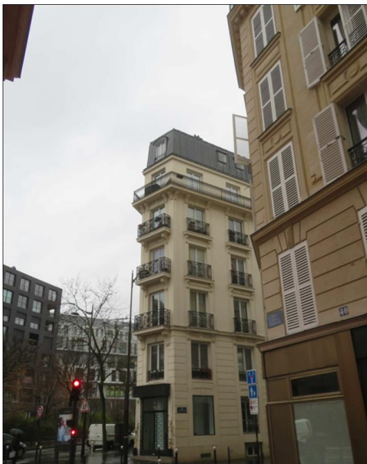
État de l'existant :
