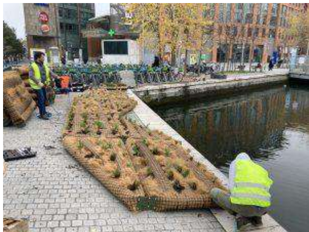
Installation du radeau végétalisé sur le canal Saint Denis, Icade
